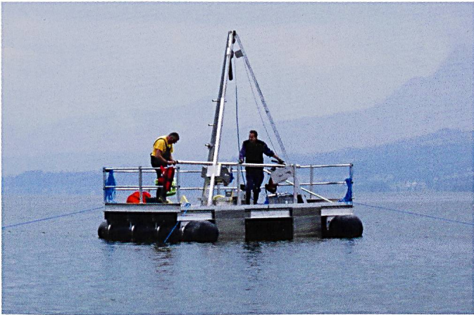
Abb. 2: Arbeitsplattform zur Abteufung von Sedimentbohrungen.
