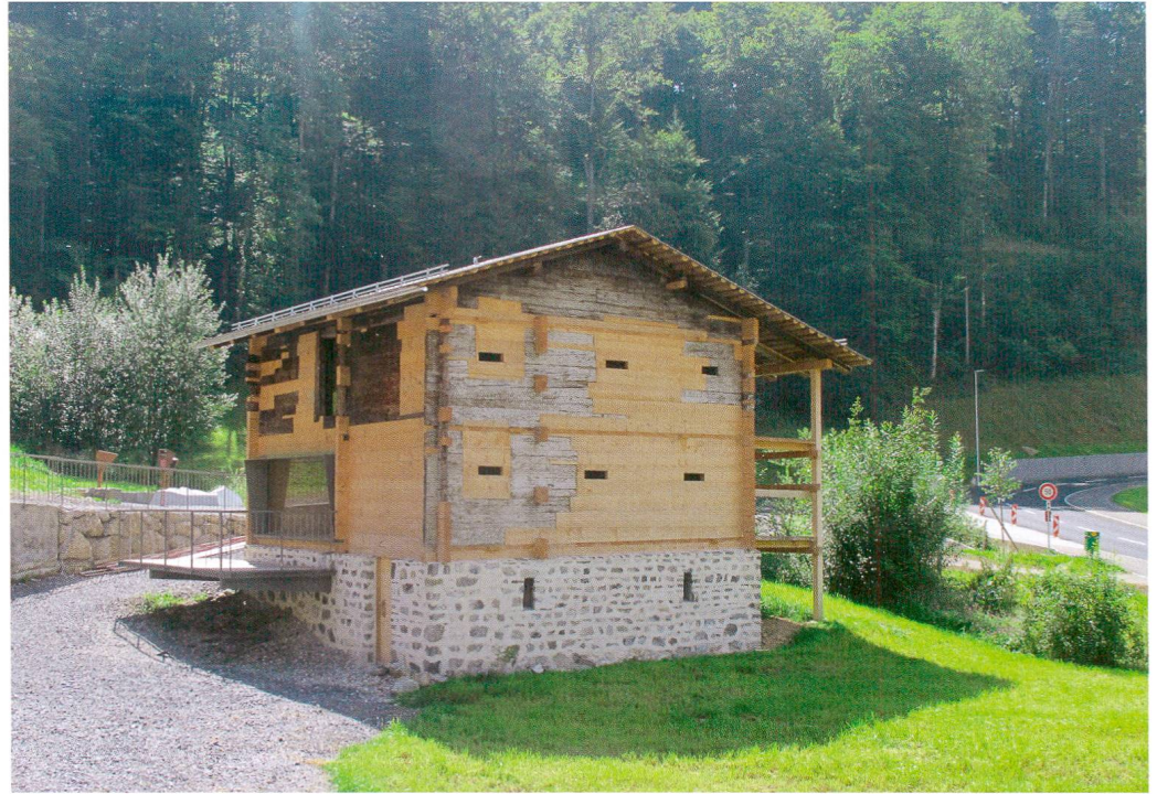
Abb. 7: Die Hauptfront des Gebäudes mit dem rekonstruierten Steinsockel in Pietra-rasa-Technik. Auf der Traufseite befindet sich die Besucherplattform.
