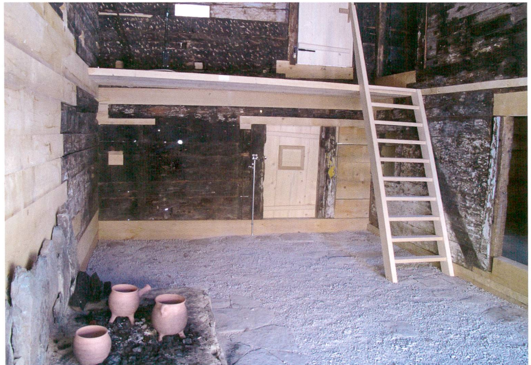
Abb. 8: Blick in die doppelstöckige Küche mit offener Feuerstelle und Ausgang ins Obergeschoss. Gut zu sehen ist eine der drei original erhaltenen Lichtöffnungen.
