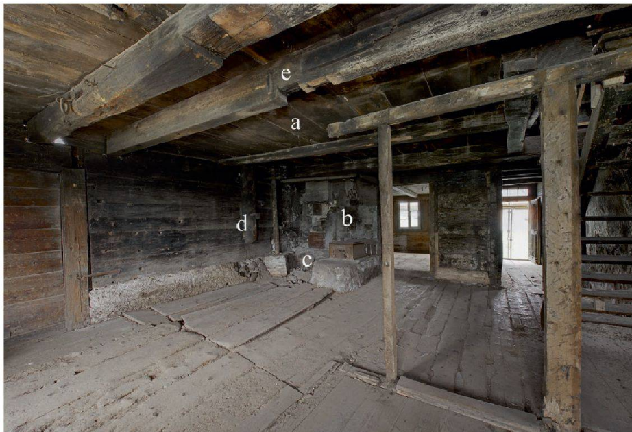
Abb. 16: Küche, Blick gegen Nordosten: im 19. Jahrhundert eingebrachte Deckenbretter (a), Einfeuerungsöffnung des Kachelofens im Nordosttrakt (b) und Wellgrube (c), die im 18. Jahrhundert notwendig gewordene Blockzange (1757/58 dendrodatiert) (d) sowie der Schwellbalken der nordwestlichen Eckkammer des zweiten Wohngeschosses mit Nut für die Aufnahme des Schwellbalkens der Süd- wand (e) im Gründungsbau von 1298.
