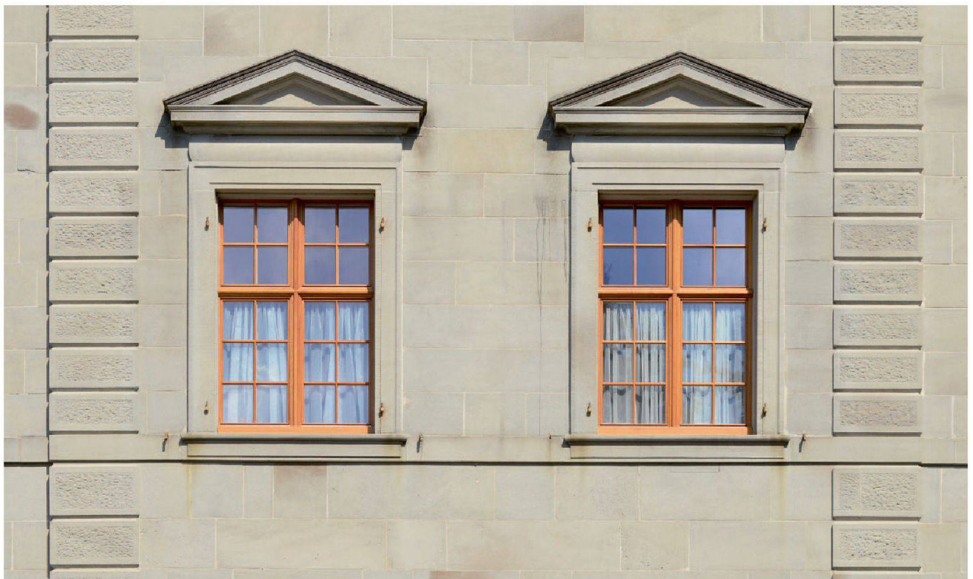
Abb. 24: Einsiedeln, Kloster, Fenster Klosterfront. Die durch das Unwetter zerstörten Fenster wurden durch neue, nach altem Vorbild gestaltete, ersetzt. Die eichenholzfarbige Behandlung konnte durch den Untersuch an einem Fenster des 18. Jahrhunderts nachgewiesen werden.
