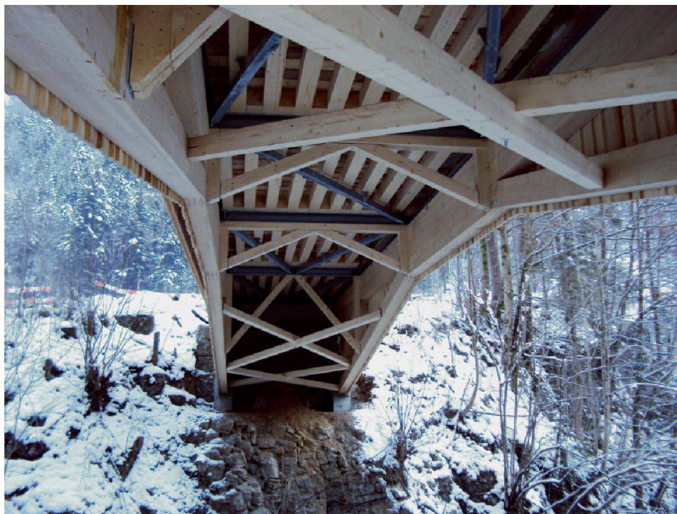
Abb. 7: Schwyz, Suworowbrücke. Blick in die Unterkonstruktion der Brücke, die mehrheitlich ersetzt werden musste.
