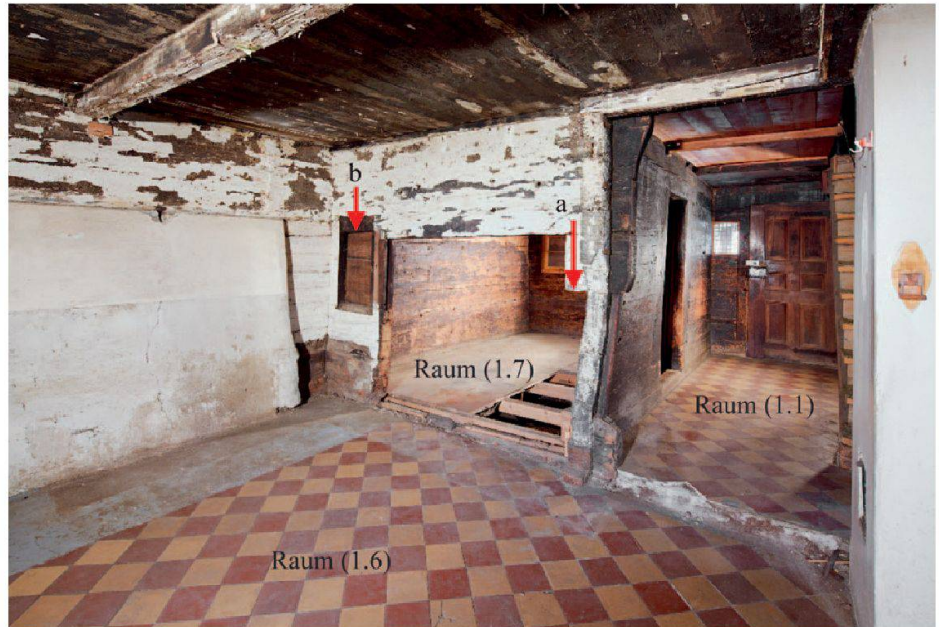
Abb. 11: Küche (1.6) gegen Nordosten, mit Aussparung für Kachelofen der hinteren Stube (1.7) (a) und nahe der Ecke gelegenen Öffnung (b), die als Durchreiche gedient haben dürfte.
