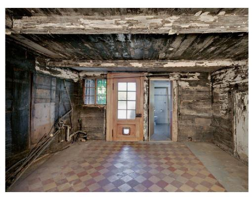
Abb. 7: Gang- und Küchenbereich (1.6) gegen Westen, mit den überformten Türöffnungen des westlichen Hauseinganges (links) und des Abortes (rechts).
