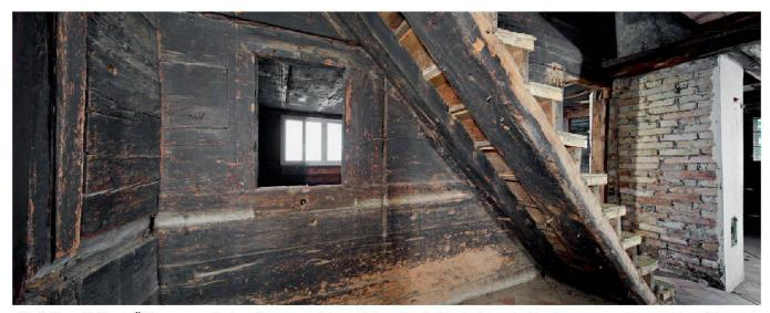
Abb. 8: Gang (1.1) mit Öffnung gegen Süden, die ursprünglich möglicherweise als Durchreiche oder Empfang, später mit gangseitigem Korpus als Wandkasten der grossen Stube (1.2) diente.
