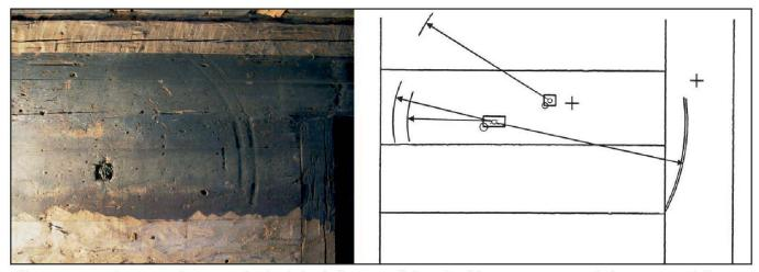
Abb. 9: Kreissegmentförmige Furchen, entstanden durch die gleichmässige, etliche Male erfolgte Bewegung einer unbekannten Gerätschaft um ein Zentrum, angetroffen an der Nordwand der grossen Stube (1.2, links) sowie an der Südwand der hinteren Stube (1.7, rechts).
