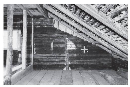
Abb. 21: Dachkammer (3.7a, linke Bildseite), Nordwand mit sekundär zugesetzter originaler Fensteröffnung (1), Nut für die Aufnahme der Binnenwand (2) sowie Dachraum (3.7b, rechte Bildseite) mit originalem(?) kreuzförmigem Heiterloch (Fensterluke) (4). Das viertelkreisförmige Heiterloch (3) stammt wohl aus dem 19. Jahrhundert.
