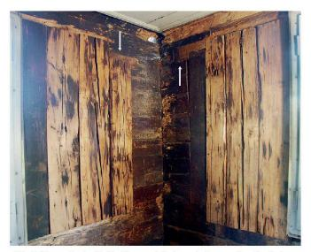
*Abb. 6:* Grosse Stube (1.2), Ost- und Südwand: Spuren der Abarbeitung über den Fensteröffnungen (Pfeile).
