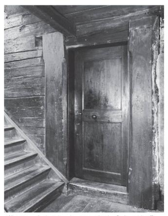
Abb. 18: Gang (1.1), Südwand, mit Mantelstüden flankierte Türöffnung zur grossen Stube (1.2).
