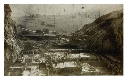
Abb. 14: Bau der Staumauer des Kraftwerks Wägital in der Schräh, um 1923/24. Im Hintergrund ist die zur Stauung vorgesehene Ebene von Innerthal zu sehen.
