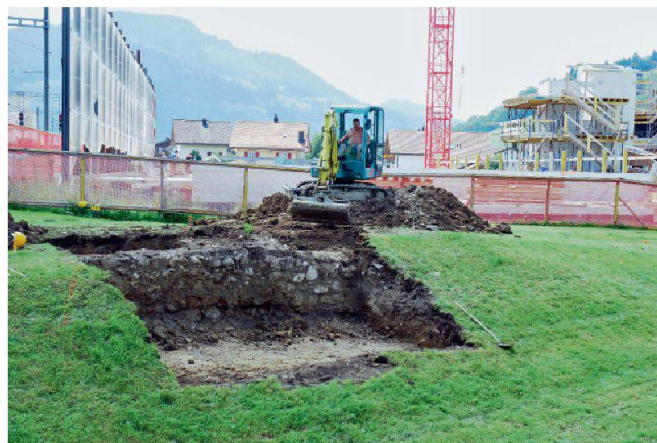
Abb. 1: Letzi Rothenthurm 2009. Freilegen des Fundamentes der Letzimauer mit Hilfe eines Kleinbaggers, von Norden. Im Hintergrund die Baustelle Schulanlage MPS (Mittelpunktschule) Berg.
