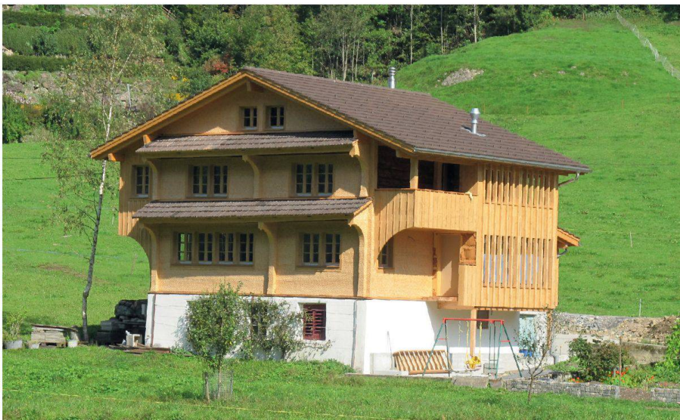
Abb. 9, links: Ehemalige Kaplanei, Ried. Die ehemalige Kaplanei gehört zu den kleinen Tätschdachhäusern im Muotatal. Dank der Hauserweiterung im Laubenbereich ist eine zeitgemässe Wohnnutzung möglich.
