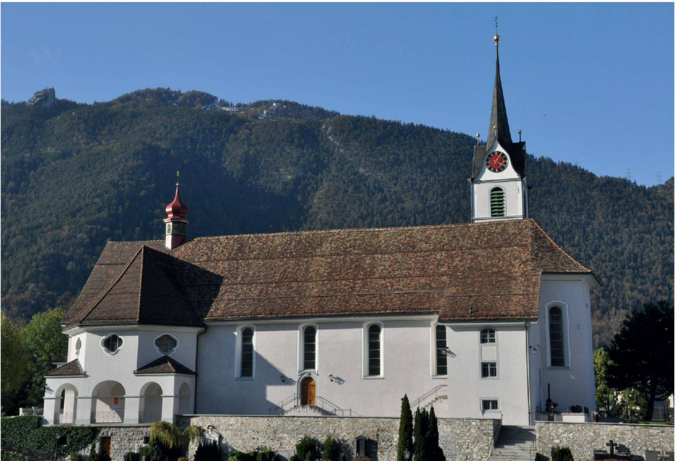
Abb. 8: Ingenbohl, Pfarrkirche St. Leonhard. Die Fassaden wurden nach Befund wieder hergestellt. Die grossen Flächen in Rauputz werden von geglätteten hellen Bändern und dunklen Linien begleitet.
