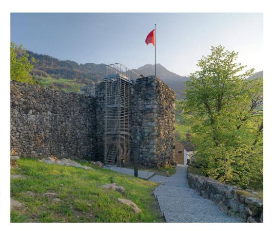
Abb. 17: Lauerz, Insel Schwanau. Der Turm ist neu mit einer Aussentreppe in Anlehnung an den ursprünglichen Aufstieg erschlossen. Der historisch falsche Zugang über die Aussenmauer wurde aufgegeben.
