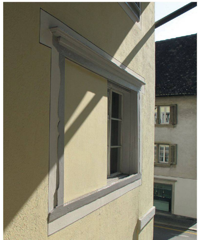
Abb. 3: Schwyz, Haus Herrengasse 6. Auf der Westseite des Hauses hat sich ein originaler Ziehladen erhalten. Die Ziehläden auf der Herrengasse-Seite wurden im 19. Jahrhundert entfernt.
