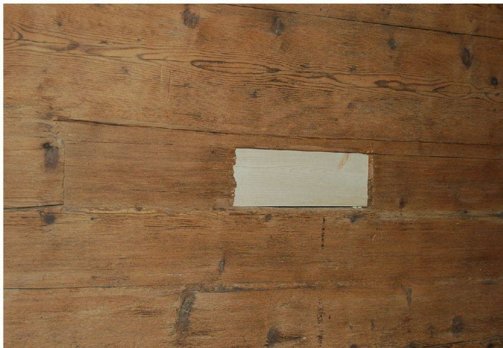
Abb. 11: Steinen, Haus Geisser, Herrengasse 15. In der Nebestube sind Fensteröffnungen aus der Bauzeit im frühen 14. Jahrhundert erhalten. Gut zu erkennen sind die Rillen, in denen Brettchen zum Verschiessen der Öffnungen eingeschoben werden konnten.
