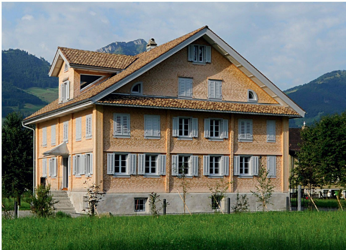
Abb. 12: Steinen, Haus Feld, Rübengasse 17. Das biedermeierliche Äussere verrät das Alter des Hauses nicht. Der Holzkern ist dendrochronologisch ins Jahr 1553 datiert. Der Mauersockel gehört dazu.
