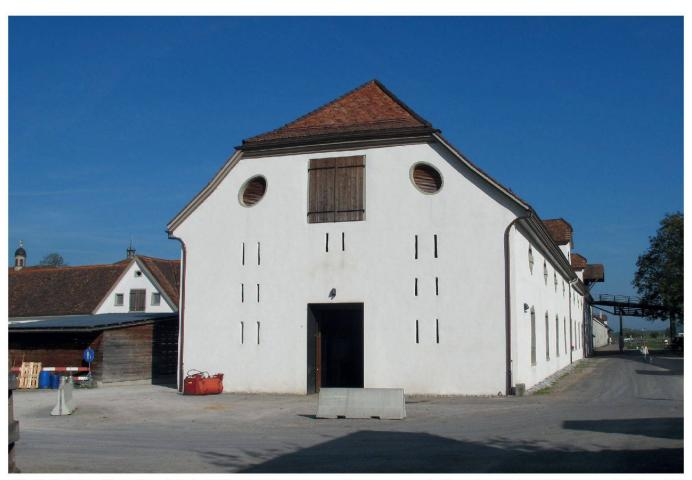
Abb. 18: Einsiedeln, Kloster, Marstall. In der Südfassade ist heute der neue Hauptzugang zum Stall integriert. Wieder geöffnet wurden die kleinen Lüftungsschlitze.
