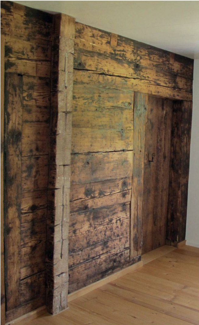
Abb. 14: Steinen, Haus Feld, Rübengasse 17. Im Obergeschoss ist die Türe aus der Bauzeit zur Laubenkammer erhalten.
