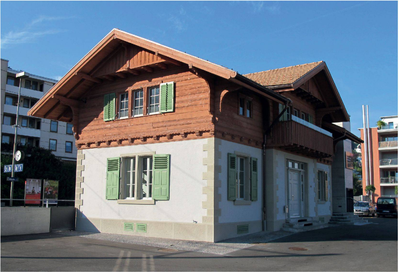
Abb. 20: Freienbach, ehemaliger Bahnhof Bäch. Im Jahr 1900 wurde der erste Bahnhof von Cham auf einem neuen Mauersockel in Bäch an der neu eröffneten Bahnstrecke von Zürich nach Chur wieder verwendet. Heute dient der Bahnhof als Vereinshaus für die Ortschaft Bäch. Dazu wurde eine neue invalidengerechte und feuerpolizeilich sichere Vertikalverbindung geschaffen.
