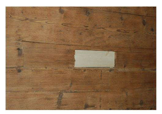
Abb. 11: Steinen, Haus Geisser, Herrengasse 15. In der Nebenstube sind Fensteröffnungen aus der Bauzeit im frühen 14. Jahrhundert erhalten. Gut zu erkennen sind die Rillen, in denen Brettchen zum Verschliessen der Öffnungen eingeschoben werden konnten.
