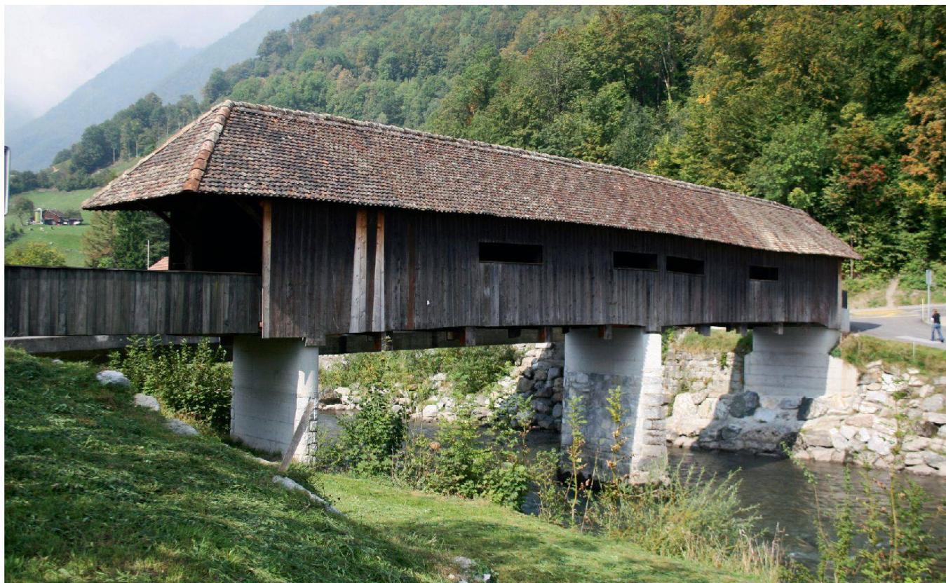
Abb. 16: Ingenbohl, Wylerbrücke. Die Brücke präsentiert sich nach dem Anheben um zirka einen Meter wesentlich besser und hat durch diese Massnahme an Dominanz gegenüber der neuen Wylerbrücke gewonnen.
