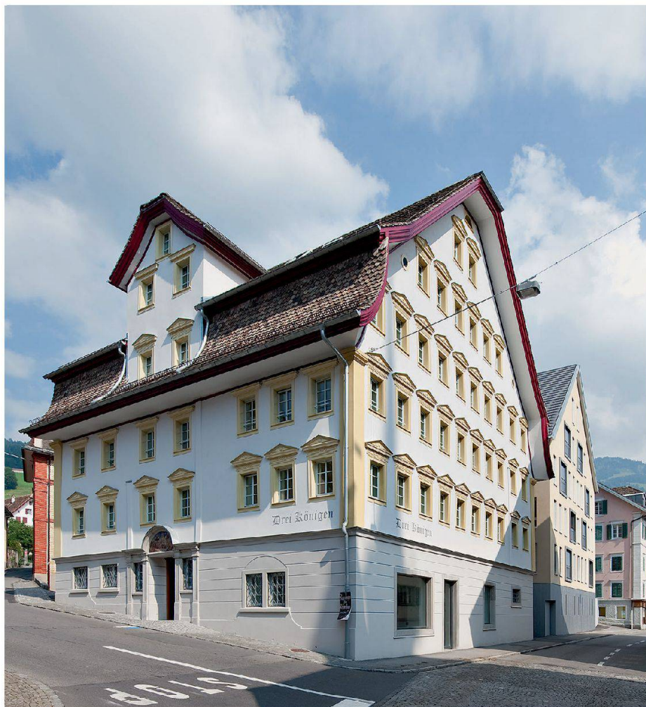
Abb. 7: Schwyz, ehemals Gasthaus Drei Königen. Im heutigen Volumen des Biedermeierbaues mit dem markanten Giebelmansarddach versteckt sich ein Strickbau, der dendrochronologisch ins Jahr 1490 datiert ist.
