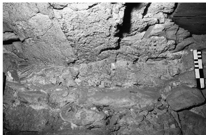
Abb. 12: Sattel SZ, Morgarten, Letziturm. Mörtelnegative der herausgerissenen hölzernen Sturzbalken hinter der Türe des Hocheingangs; von E.
