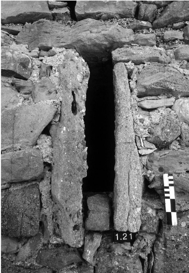
Abb. 16: Sattel SZ, Morgarten, Letzturm. Schartenfenster mit zwei hochkant gestellten Sandsteinplatten als Gewände auf der Nordseite des 2. Obergeschosses; von N.
