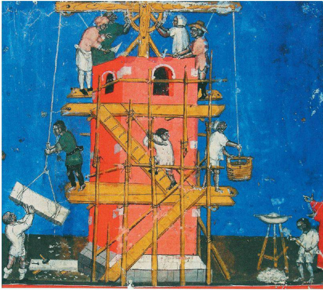
Abb. 18: Sattel SZ, Morgarten, Letziturm. Spätmittelalterliche Darstellung einer Baustelle mit Kran und einem Stanggengerüst mit Laufschräge. Rudolf von Ems, Weltchronik, 1385.
