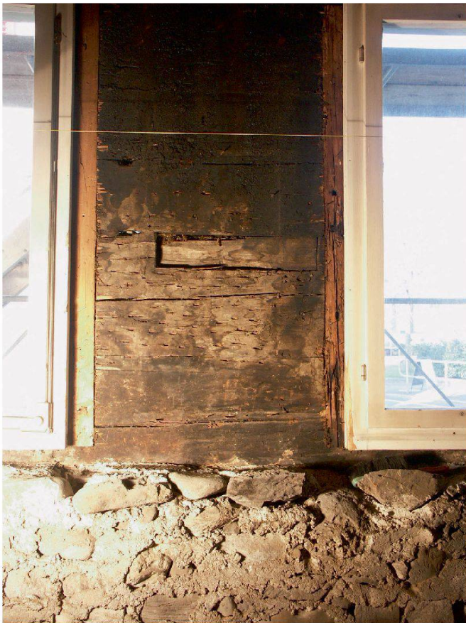
Abb. 6: Westwand der offenen Rauchküche (1.5), originaler Fensterschlitz.
