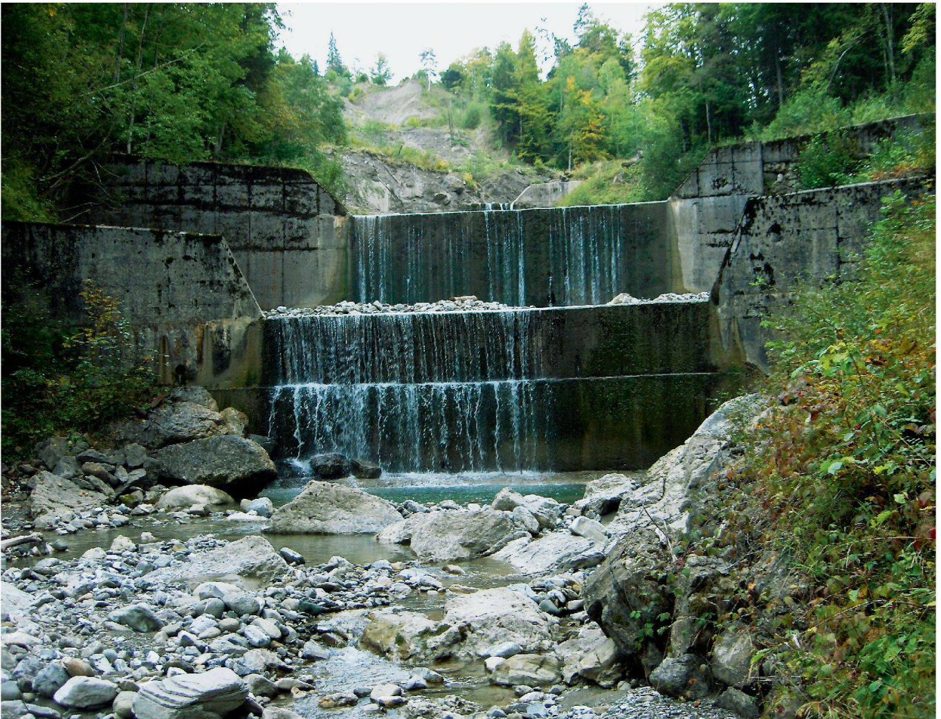
Verbauung im Chratzerlibach, Gemeinde Vorderthal.
