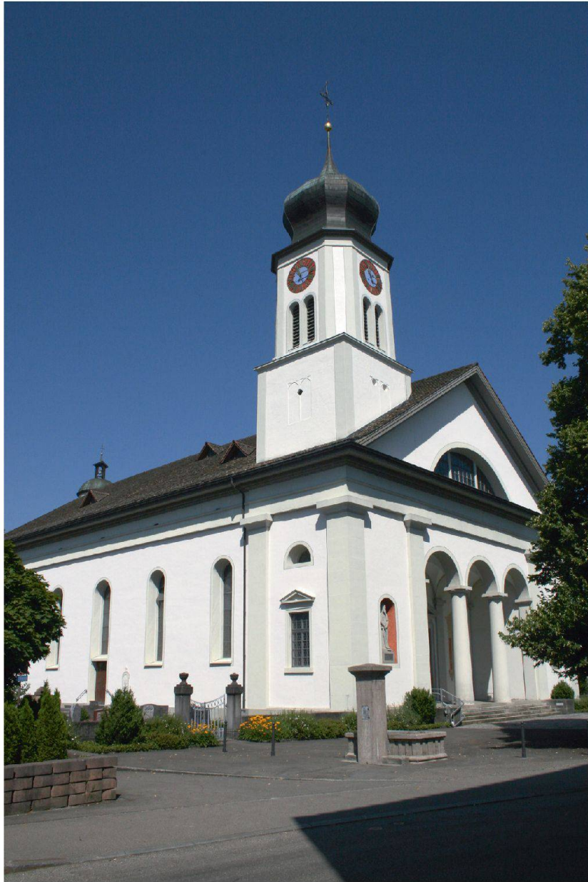
Die heutige Pfarrkirche St. Martin wurde auf Betreiben des ersten «eigenen» Pfarrers von Galgenen, Jakob Franz Riesch, ab 1822 erbaut.
