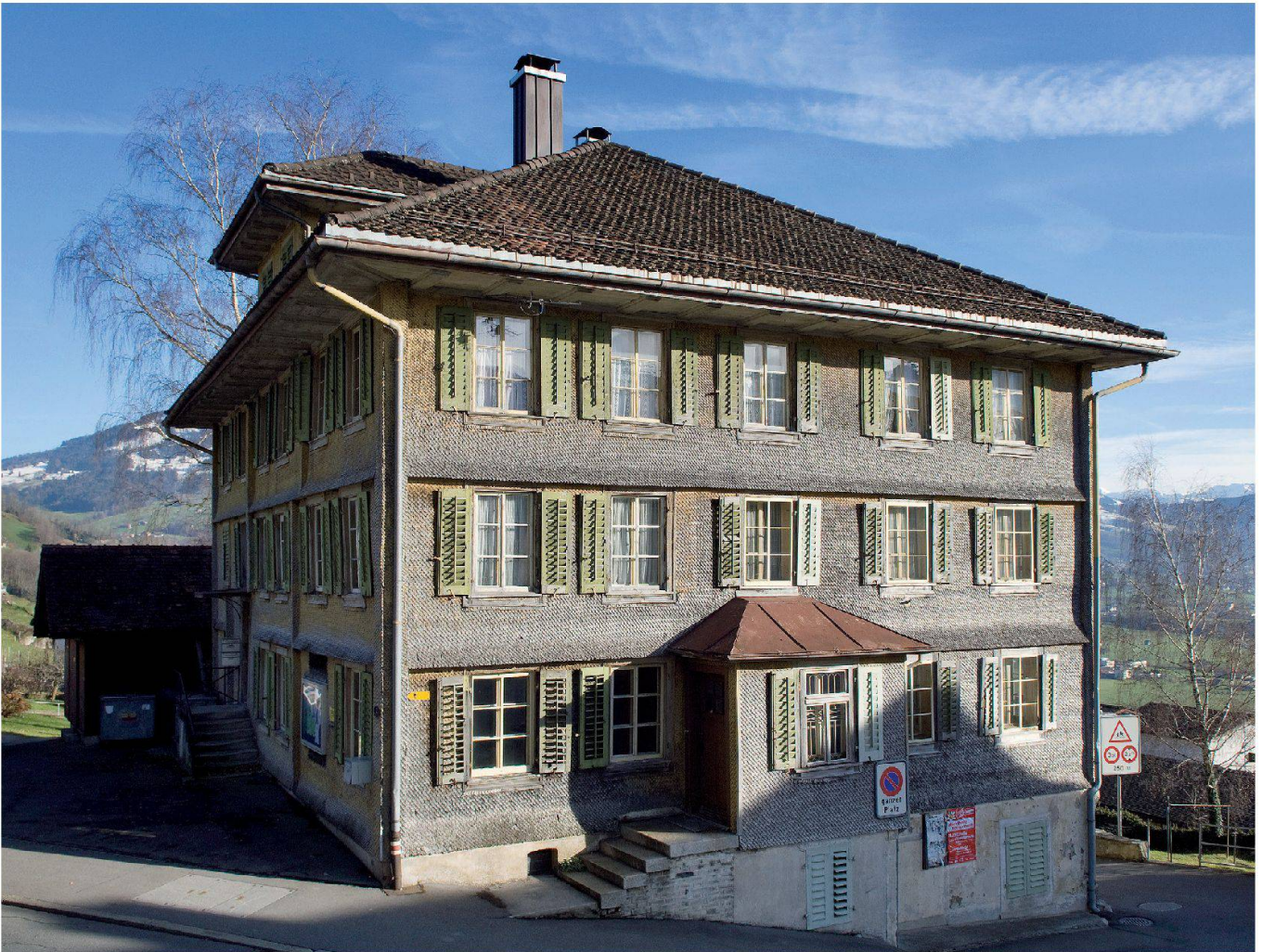
Der Aufenthaltsort der Schwestern vom Kostbaren Blut in Steinerberg, das alte Pfarrhelferhaus.
