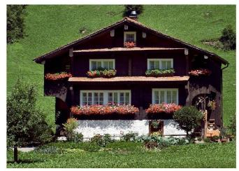
Die zwei Muotathaler Bauernhäuser Hoftrog und Tristel, beide im frühen 19. Jahrhundert erbaut, sind typische Beispiele der beiden Bauernhaustypen im Muotatal. Das Haus Hoftrog mit Steildach war von Anfang an mit Tonziegeln gedeckt, während auf dem flachgeneigten Dach des Hauses Tristel Holzschindeln lagen.
