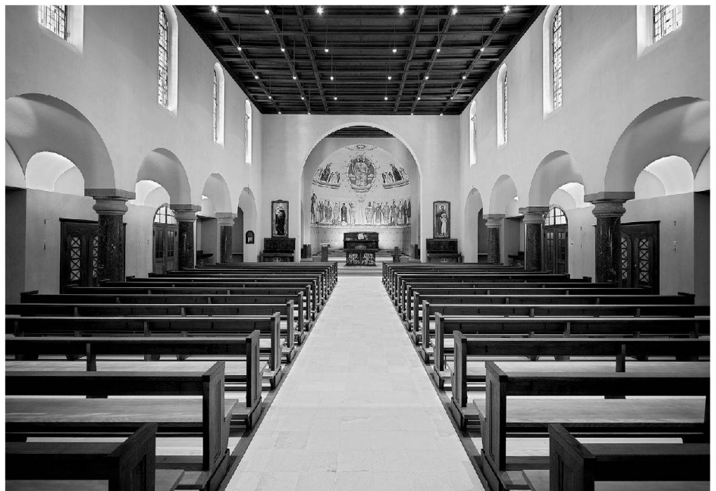
Abb. 16: Küssnacht, Pfarrkirche St. Sebastian, Immensee. Mit den kräftigen polierten Säulen aus Castione-granit, die die schmalen Seitenschiffe abtrennen, der hölzernen Flachdecke und dem Rundchor mit der Kalotte wird die Anlehnung an eine frühchristliche Kirche gesucht.
