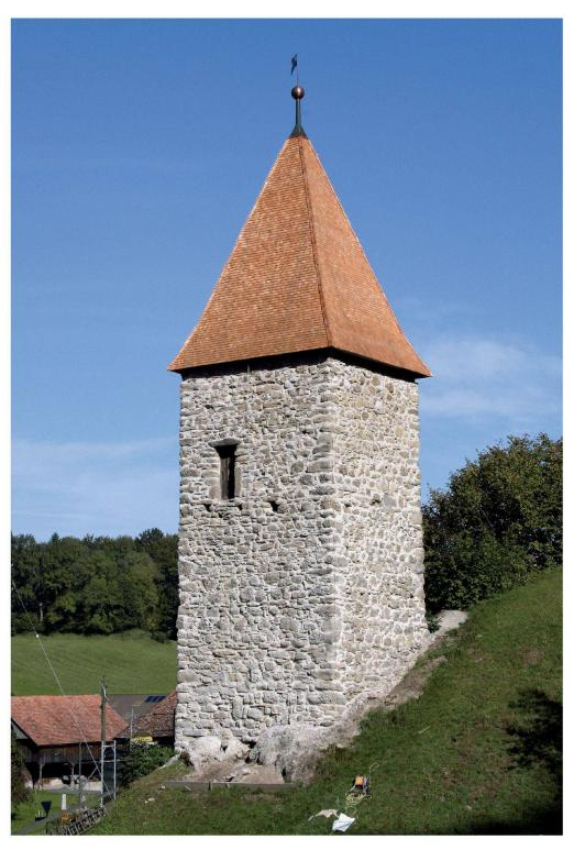
Abb. 5: Sattel, Letziturm. Die Restaurierungsarbeiten am Turm beschränkten sich auf konservierende Massnahmen an Dach und Mauerwerk.
