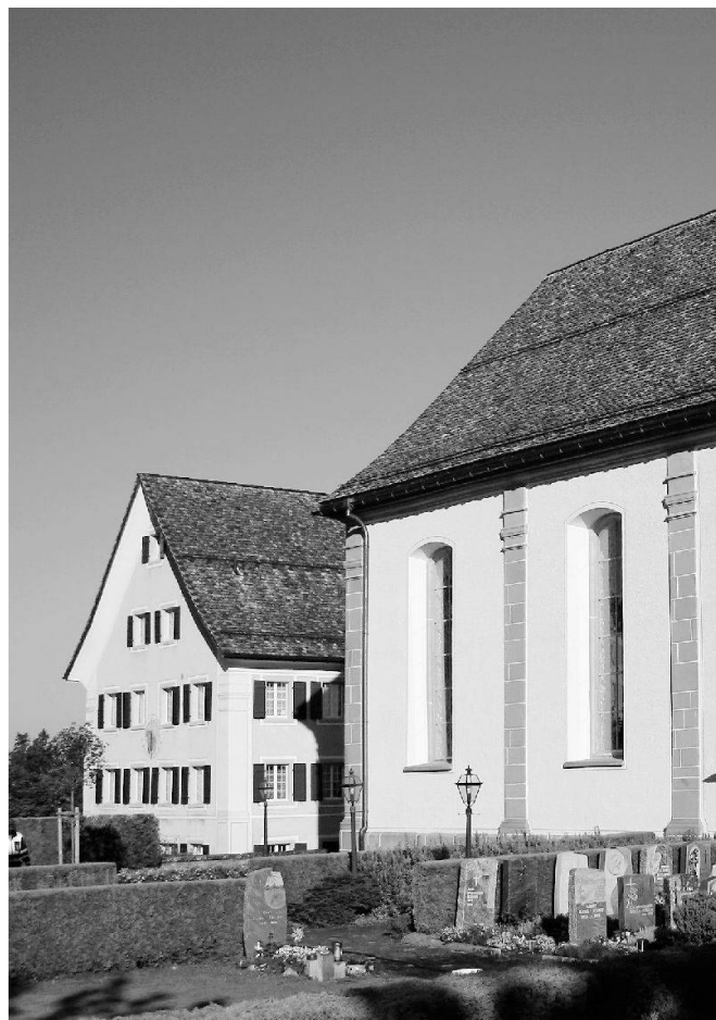
Abb. 18: Feusisberg, Pfarrkirche St. Jakobus. Kirche und Pfarrhaus besitzen eine identische Fassadengestaltung, wobei beim Pfarrhaus die Eckpilaster, die an der Kirche in Sandstein bestehen, lediglich aufgemalt sind.
