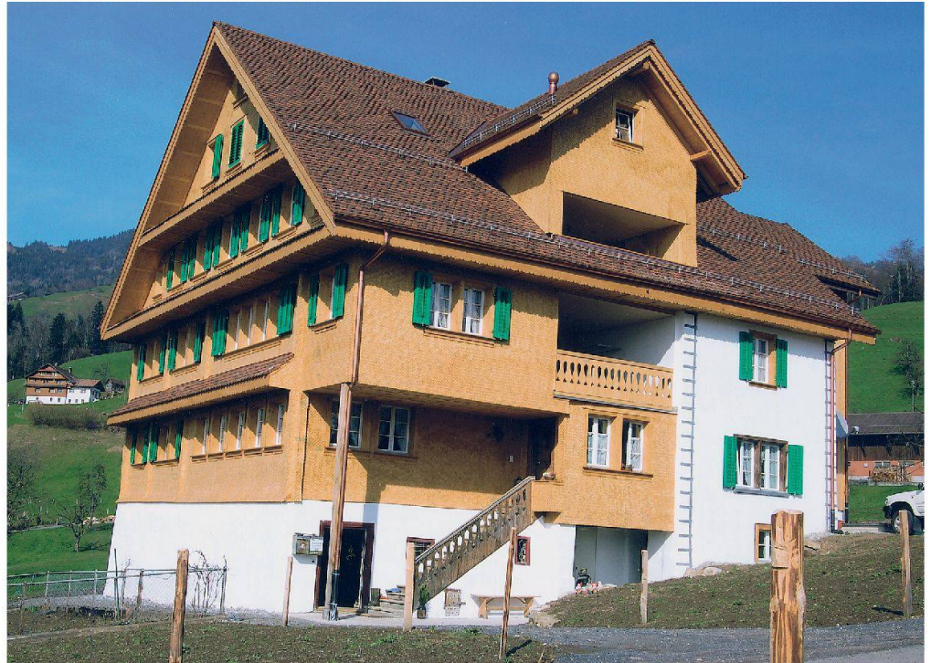
Abb. 3: Schwyz, Hinteres Herrenfeld (Nauerhaus). Beim imposanten Bauernhaus sind deutlich der bergseitige massiv gemauerte und der talseitige in Holz ausgeführte Teil zu unterscheiden.
