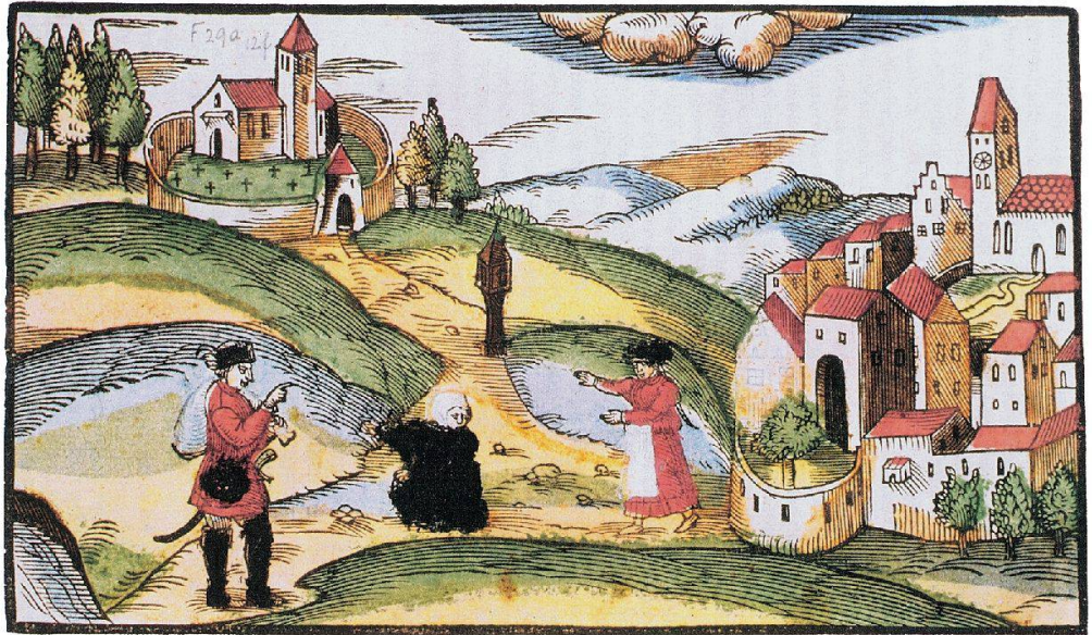
Abb. 1: Älteste Darstellung von Uznach auf einem Flugblatt über die Heilung des Linthport-Anneli aus dem Jahre 1580. Rechts das Städtchen Uznach mit der Michaelskirche (auch Antoniuskirche genannt) und dem Spitalgebäude mit einem charakteristischen Treppengiebel. Links die alte Pfarrkirche, auch Kreuzkirche genannt. Original in der Sammlung Wickiana der Zentralbibliothek Zürich.
