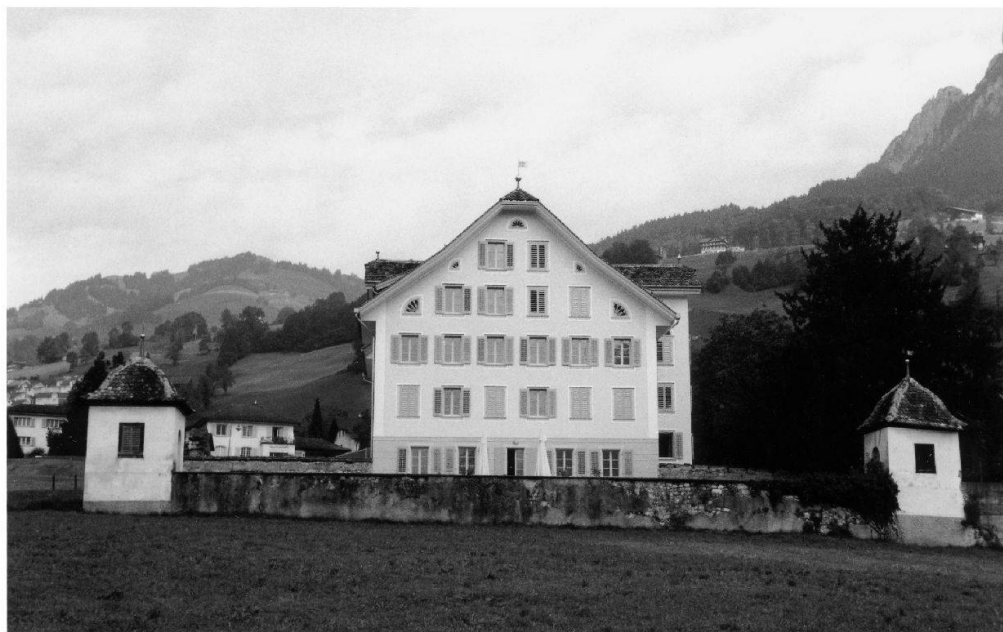
Abb. 1: Schwyz, Mittleres Feldli. Das Herrenhaus von Süden nach der Restaurierung. Das Sockelgeschoss ist durch die dunklere Bemalung und die aufgemalten Linien, die Lagerfugen vortäuschen, deutlich von den Obergeschossen zu unterscheiden.
