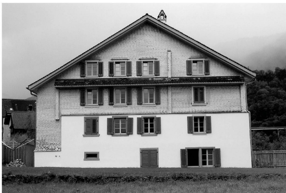
Abb. 12: Arth, Alte Post Oberarth. Für die Rückseite ist die doppelstöckige massive Mauer typisch. Im Vordergrund sind die Reste der spätmittelalterlichen Letzmauer zu erkennen.
