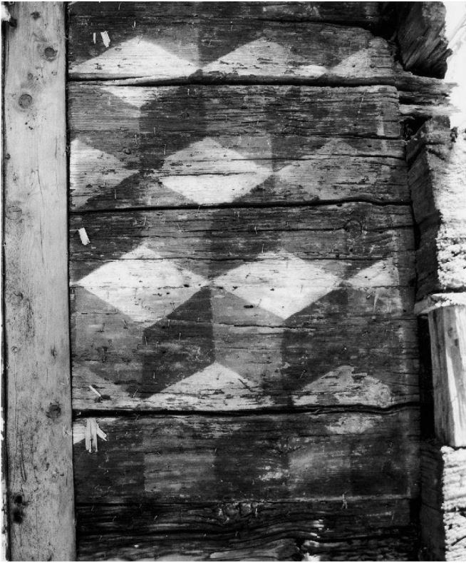
Abb. 26: Küssnacht, Haus zur Sonne . Im Giebel dreieck der Hauptfassade fanden sich in Rot- und Weissönen aufgemalte Rauten, die wohl Fensterläden imitieren sollten. Diese Dekoration gehört vermutlich ins 17. Jahrhundert.
