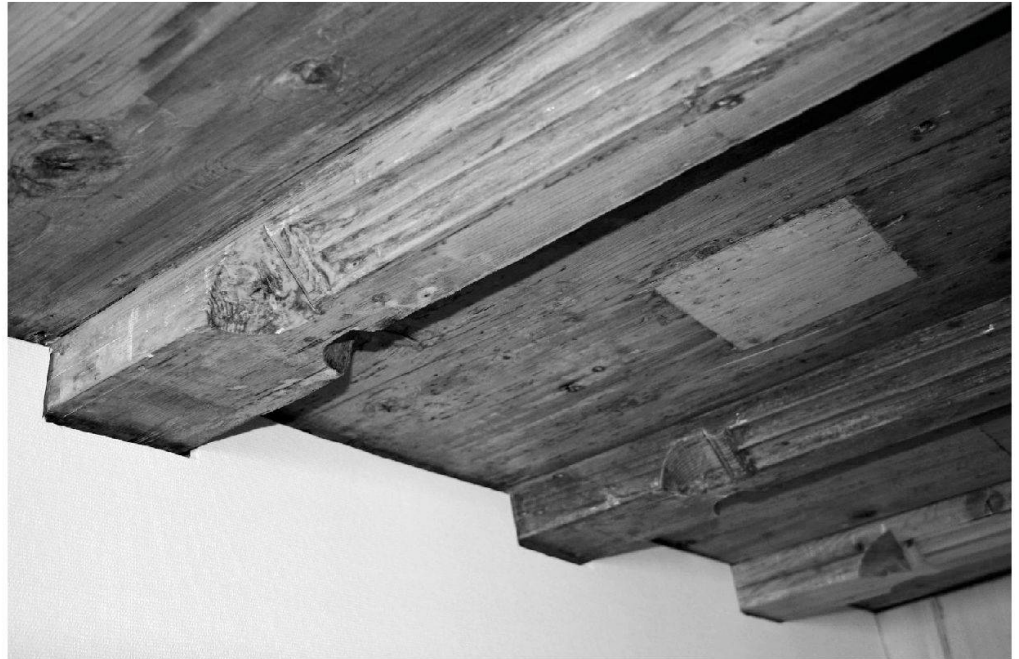
Abb. 28: Küssnacht, Haus zur Sonne. In der grossen Stube und in einem rückseitigen Zimmer des ersten Obergeschosses hat sich die gotische Balkendecke aus der Bauzeit erhalten.
