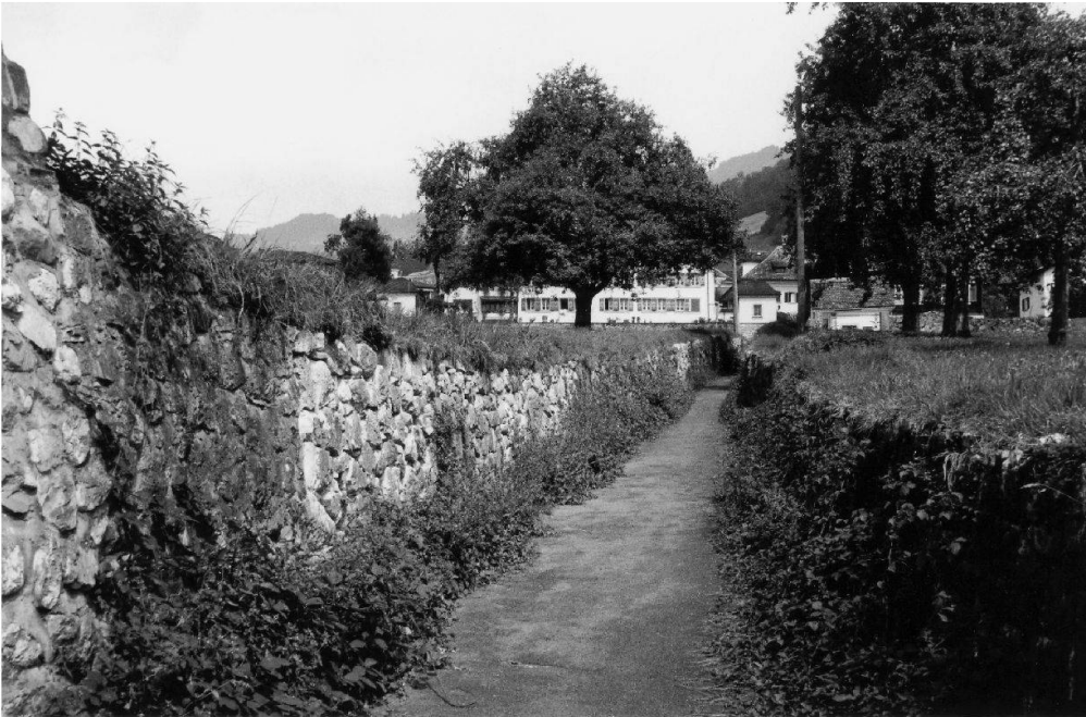
Abb 7: Schwyz, St. Karligasse. Die westseitige Mauer der Gasse nach der Sanierung.
