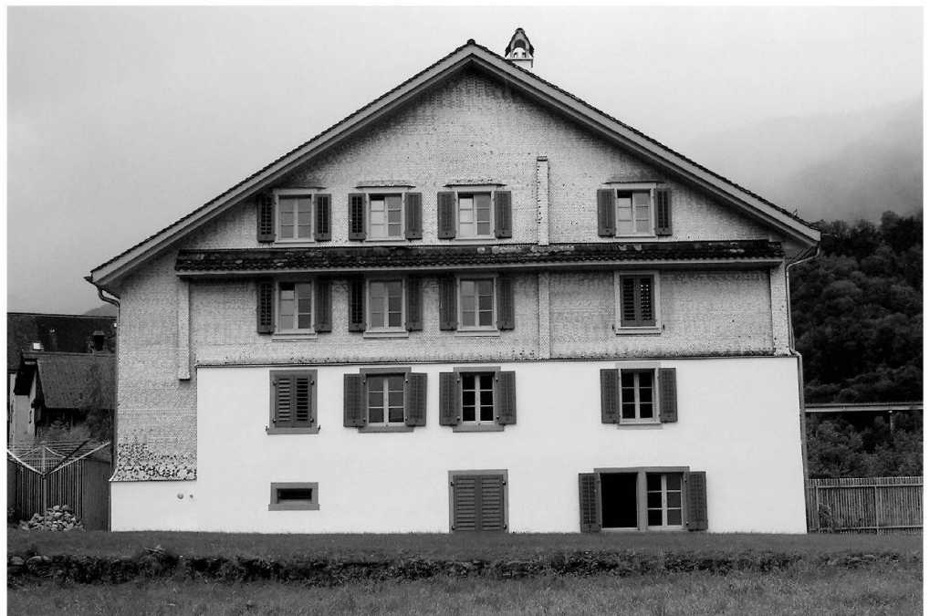
Abb. 12: Arth, Alte Post Oberarth. Für die Rückseite ist die doppelstöckige massive Mauer typisch. Im Vordergrund sind die Reste der spätmittelalterlichen Letzimauer zu erkennen.
