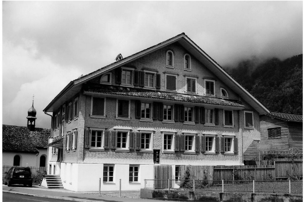
Abb. 11: Arth, Alte Post Oberarth. Die Hauptfassade nach der Restaurierung. Der Zustand des 19. Jahrhunderts mit Schindelschirm und regelmässiger Fensteranordnung wurde beibehalten.
