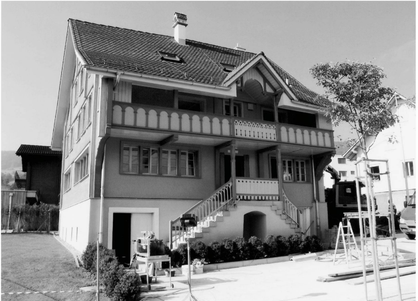
Abb. 16: Altendorf, Breitenhof. Durch die Veränderungen um 1900 wurde die dorzugewandte Traufseite zur Hauptfassade aufgewertet. Die ehemalige verschindelte Hauptfassade, links zu erkennen, wurde dadurch zur untergeordneten Nebenfront.
