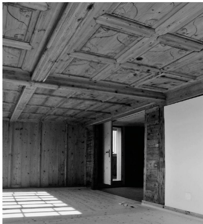
Abb. 19: Altendorf, Breitenhof. Die beiden Stuben im Erdgeschoss besitzen noch die Wand- und Deckentäfer des 18. Jahrhunderts. Rechts die gemauerte Ofenwand.
