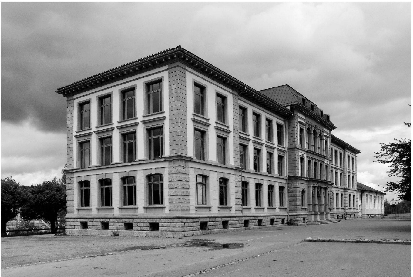
Abb. 21: Einsiedeln, Schulhaus Brüel . Das Schulhaus von Süden. Die Hauptfront wird durch den vortretenden Mittelrisalit betont. Die Fenstergliederung entspricht wiederum der ursprünglichen.
