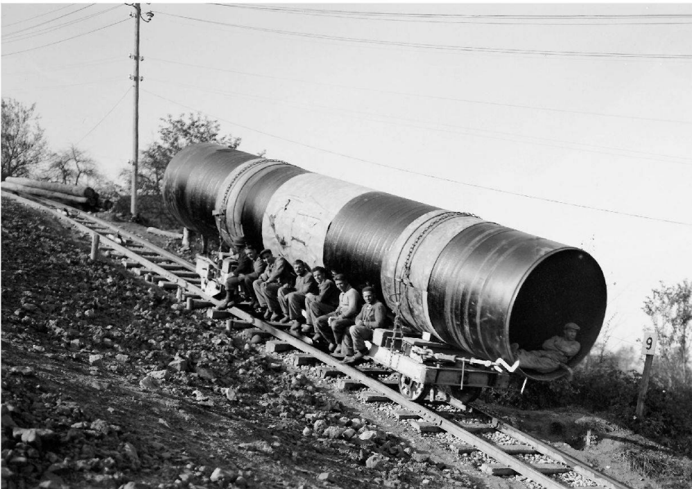
Abb. 40: Etzelwerk Altendorf, 24. Oktober 1936 (Foto W. Marthaler, Stella-Photo, Einsiedeln).
