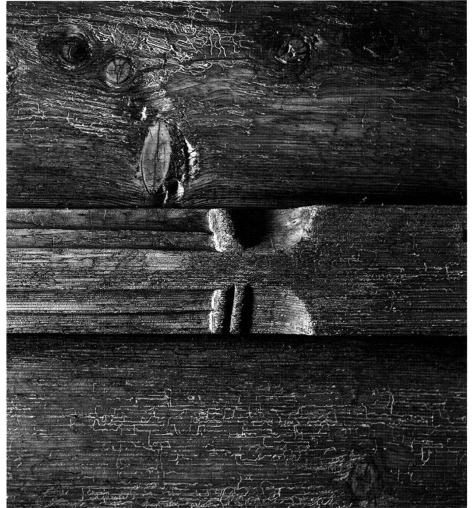
Abb. 11: Erstes Wohngeschoss, Kammer 1.6, profilierter Balken der Bohlen-Balkendecke.
