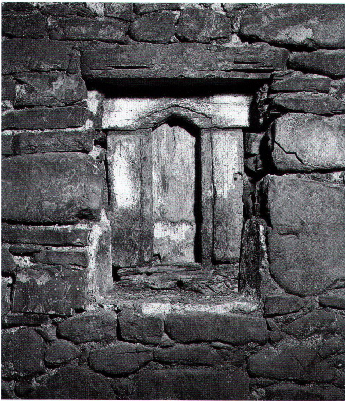
Abb. 26: Erdgeschoss/Kellerraum 0.2, Westwand. Fensteröffnung mit hölzernen Rahmen.
