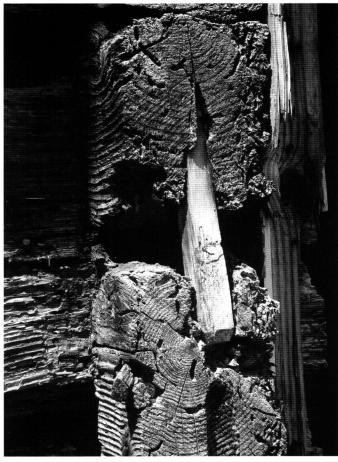
Abb. 9: Südfassade, sekundär abgesägte Vorstösse mit eckigem Holzdübel.
