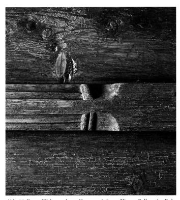
Abb. 11: Erstes Wohngeschoss, Kammer 1.6, profilierter Balken der Bohlen-Balkendecke.
