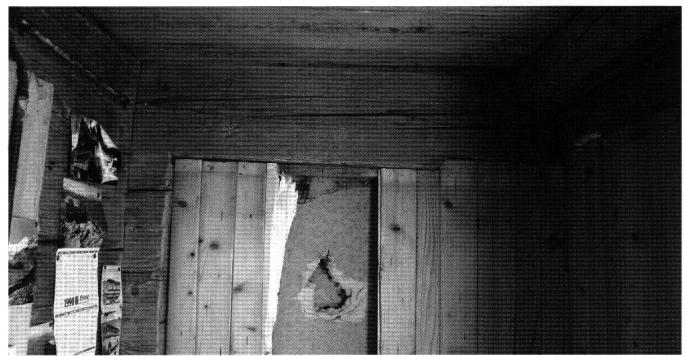
Abb. 29: Erstes Obergeschoss, Südwand von Raum 1.3. Der oberste Wandbalken als Rest einer Stützkonstruktion für die auskragende Kammer des zweiten Obergeschosses.
