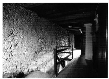
Abb. 41: Zweites Obergeschoss, Gang 2.2, Ansicht gegen Nordosten. Deutlich zu erkennen ist die unverputzte Spannmauer zwischen den beiden Eckräumen.
