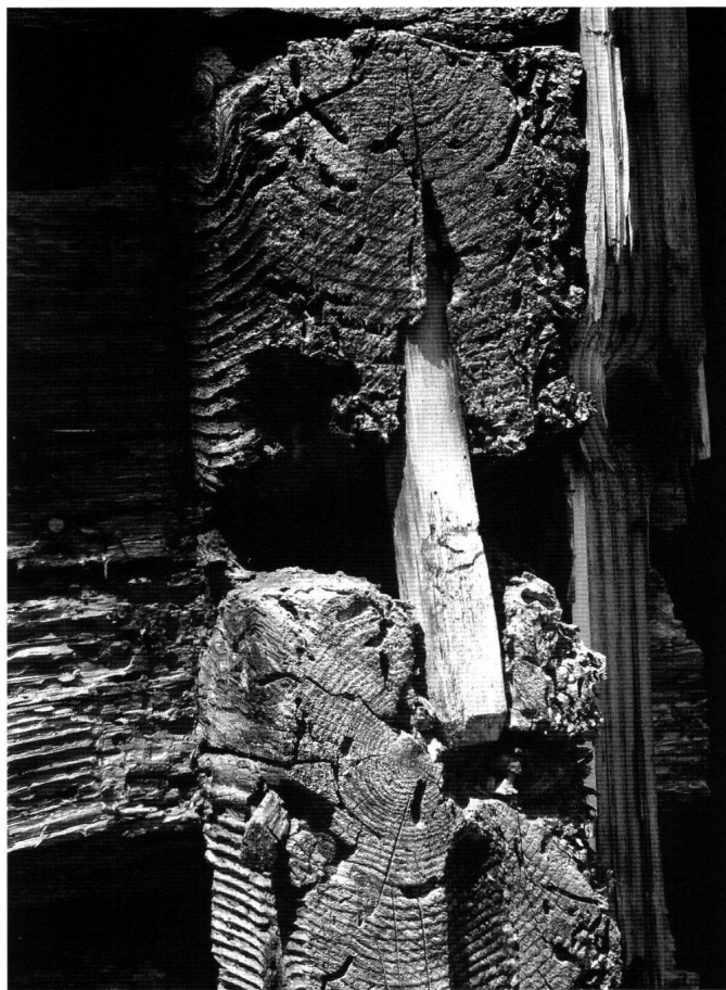
Abb. 9: Südfassade, sekundär abgesägte Vorstösse mit eckigem Holzdübel.
