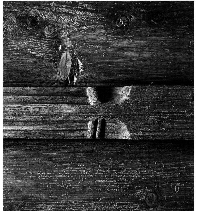
Abb. 11: Erstes Wohngeschoss, Kammer 1.6, profilierter Balken der Bohlen-Balkendecke.
