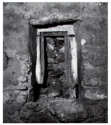
Abb. 27: Erdgeschoss/Kellerraum 0.2, Binnenwand. Fensteröffnung mit hölzernen Rahmen.
