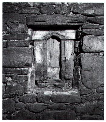
Abb. 26: Erdgeschoss/Kellerraum 0.2, Westwand. Fensteröffnung mit hölzernen Rahmen.
