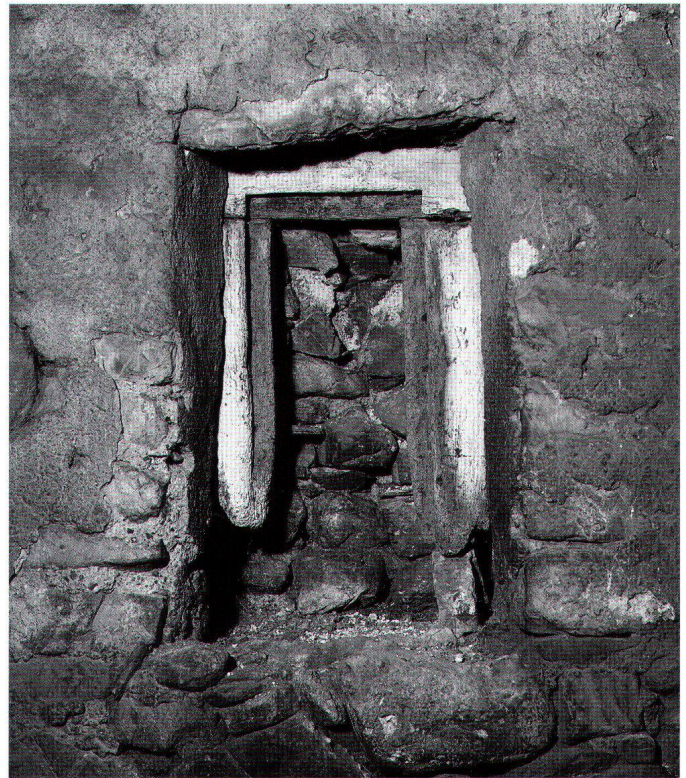
Abb. 27: Erdgeschoss/Kellerraum 0.2, Binnenwand. Fensteröffnung mit hölzernen Rahmen.
