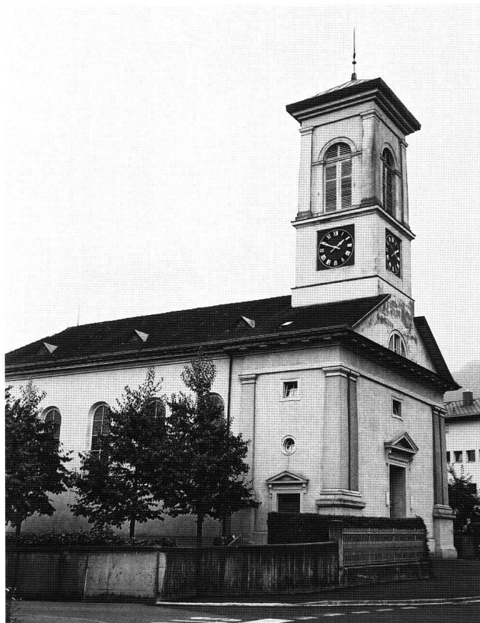
Abb. 16: Schübelbach, Reformierte Kirche Siebnen. Zustand der Fassaden zwischen 1963 und der jetzt abgeschlossenen Restaurierung.
