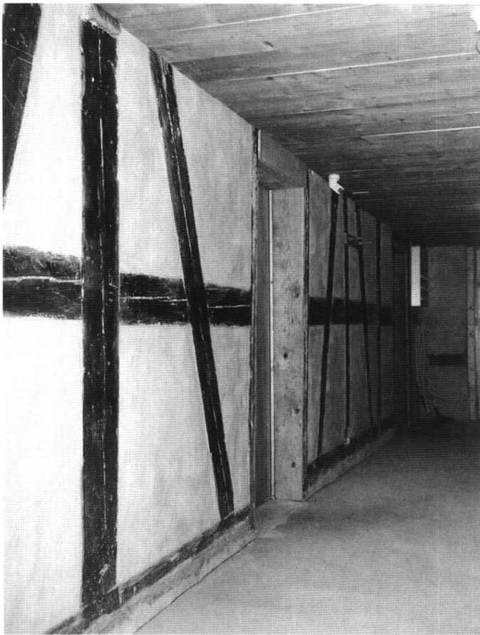
Abb. 8: Muotathal, Haus Büchsenen. Die Wände des unteren längs zum First verlaufenden Hausgangs sind als Fachwerk konstruiert. Normalerweise bestehen diese aus Bruchsteinmauerwerk.
