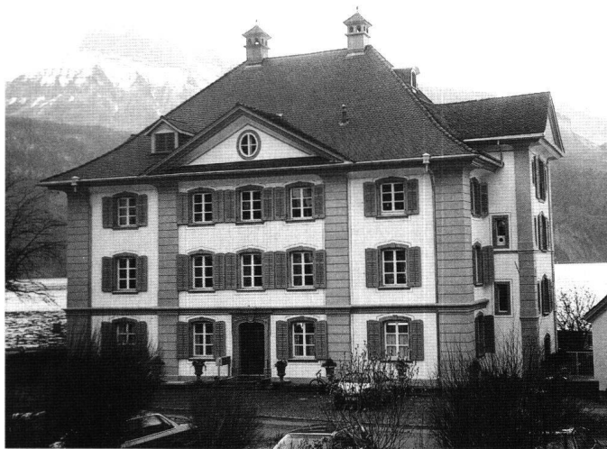
Abb. 12: Gersau, Haus Minerva. Das Haus Minerva ist das eleganteste unter den Gersauer Seidenherrenhäusern. Die wiederhergestellte, diskrete Fassadengliederung unterstreicht diesen Eindruck.
