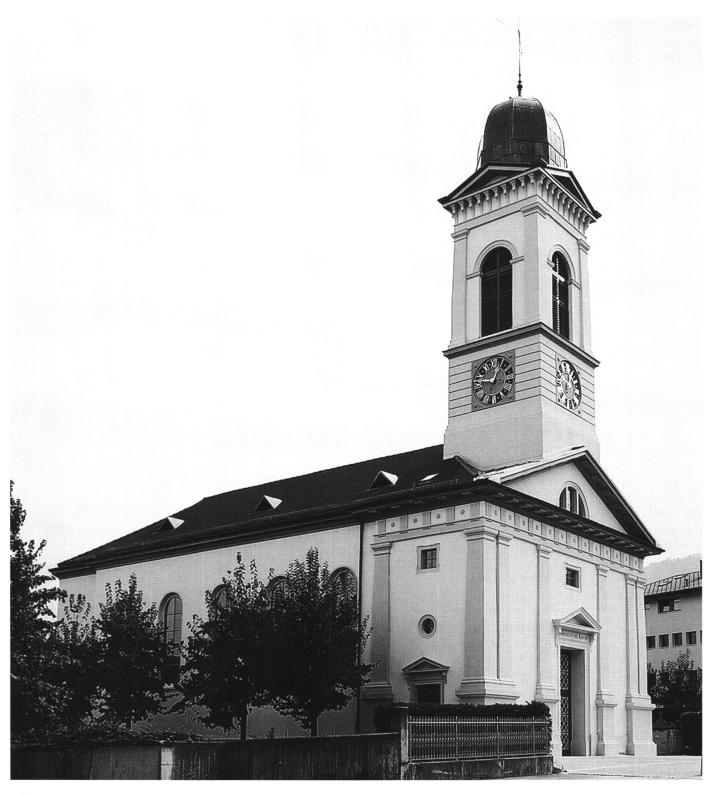
worden. Zudem wurde der Originalverputz entfernt und das ganze Äussere mit einem harten Kalkzementputz und Dispersionsfarbe überzogen.
