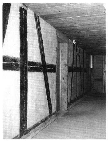
Abb. 8: Muotathal, Haus Büchsenen. Die Wände des unteren längs zum First verlaufenden Hausgangs sind als Fachwerk konstruiert. Normalerweise bestehen diese aus Bruchsteinmauerwerk.
