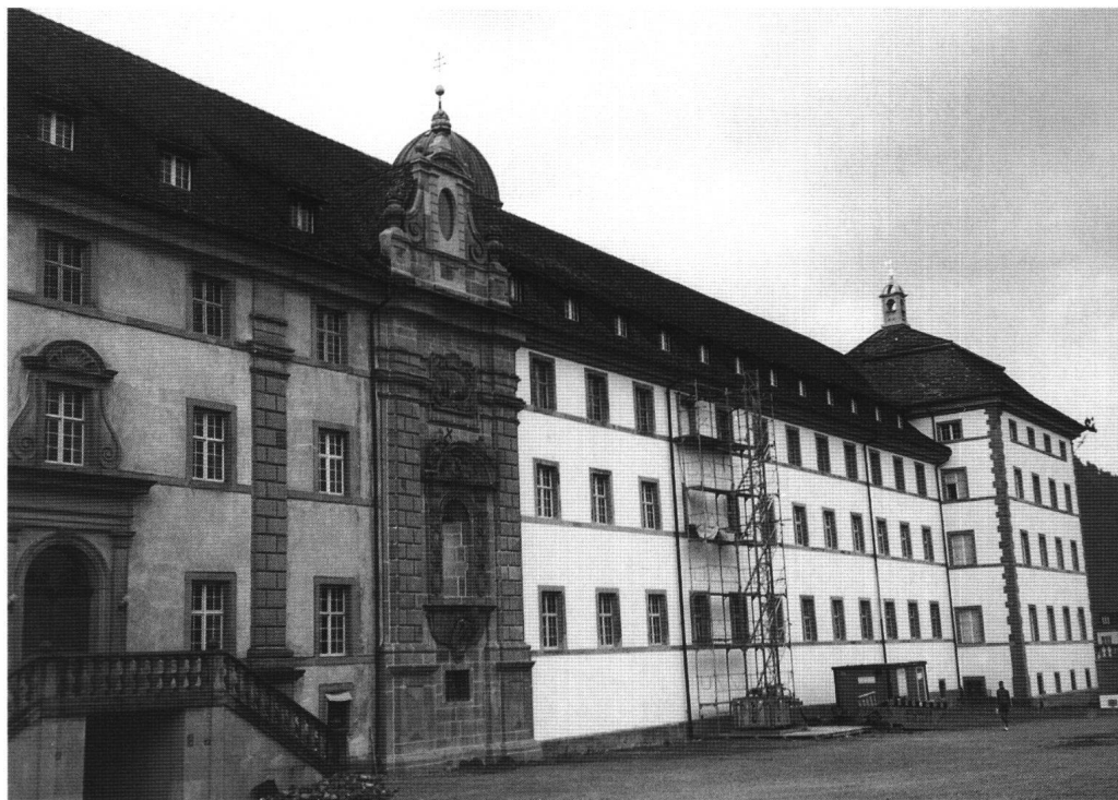
Abb. 19: Einsiedeln, Kloster, Nordfassade. Die lange Nordfassade ist zur Hälfte restauriert, wobei der Sanierung und Erhaltung der im wesentlichen original erhaltenen Sandsteinpartien, wie beim Risalit, besondere Beachtung geschenkt wurde.
