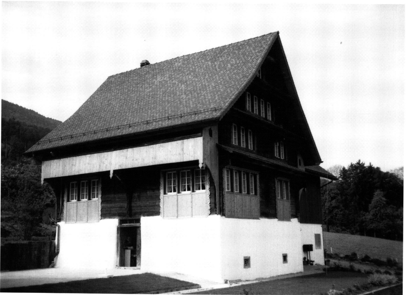
Abb. 26: Freienbach, Bauernhaus Oberwacht 27. Trotz der starken Verpflichtung in der barocken Bautradition in der Gesamterscheinung zeigt das Haus mit dem ebenerdigen Hauptzugang und den schmalen Lauben bereits klassizistische Tendenzen.
