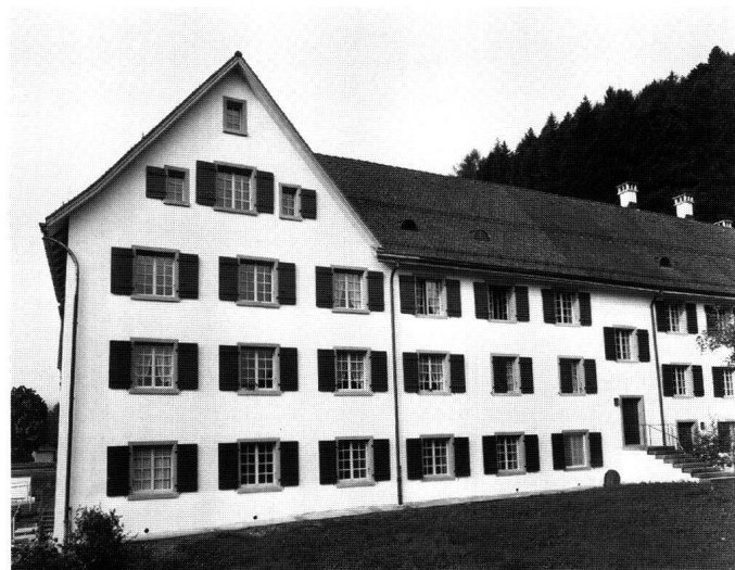
Abb. 22: Einsiedeln, Kloster in der Au, Trachslau. Der rekonstruierte Giebel auf der Nordfassade. Dieser bildet das Pendant zum original erhaltenen Giebel auf dem nordwestlichen Eckkrisalit.
