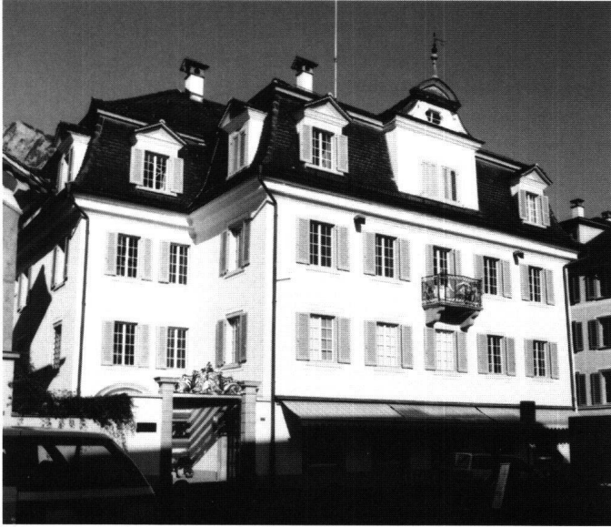
Abb. 2: Schwyz, Hotel Hediger. Besondere Aufmerksamkeit wurde bei der Aussensanierung des stark französisch beeinflussten Gebäudes der Restaurierung des Balkongeländers und dem geschmiedeten Portalaufsatz geschenkt.
