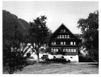
Abb. 17: Schübelbach, Haus Ziegelhof. Unter der Vertäferung des ersten Wohngeschosses verbirgt sich ein ca. 250 Jahre älterer Kern. Vermutlich wurde das Haus 1807 aufgestockt und erweitert.
