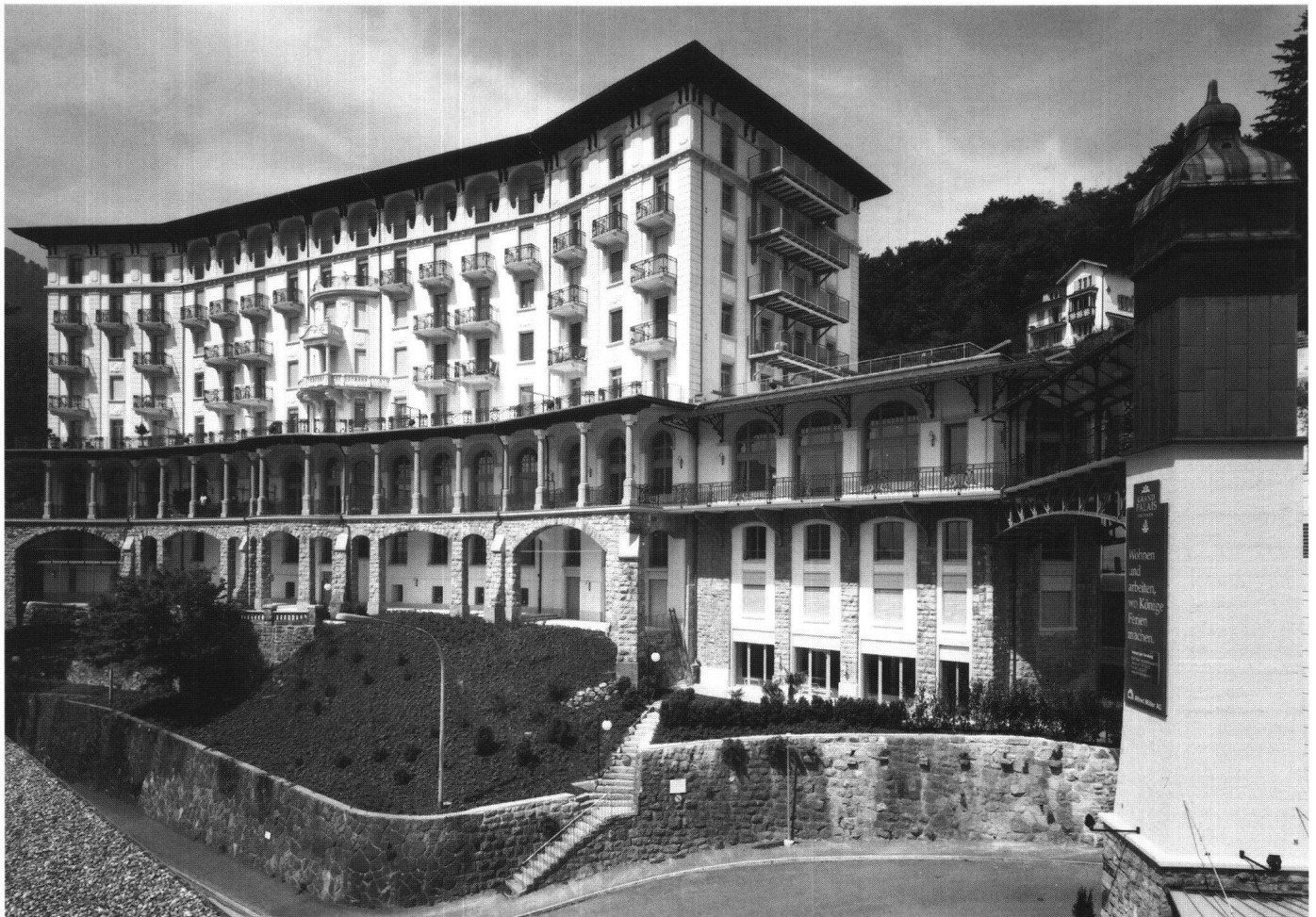
Abb. 5: Ingenbohl, Grand Palais (ehemals Grand Hotel), Brunnen. Die Hauptfassade des Hotels öffnet sich mit den beiden diagonal gestellten Seitenflügeln Richtung See, so dass von allen Zimmern aus ein bestmöglicher Ausblick geboten wird. Rechts im Bild der Lift mit der Metallbrücke zum Hauptbau.
