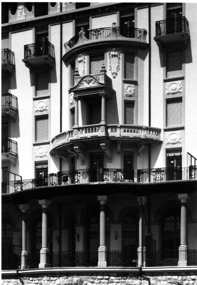
Abb. 6: Ingenbohl, Grand Palais (ehemals Grand Hotel), Brunnen. In der Fassadenmitte steht über der breiten gedeckten Terrasse ein dreigeschossiger Erker mit reichen Stuckaturen. Die geschmiedeten Balkongeländer zeigen Jugendstilornamente.
