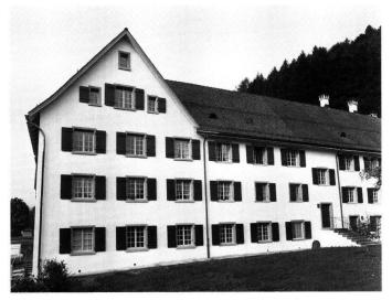
Abb. 22: Einsiedeln, Kloster in der Au, Trachslau. Der rekonstruierte Giebel auf der Nordfassade. Dieser bildet das Pendant zum original erhaltenen Giebel auf dem nordwestlichen Eckrisalit.
