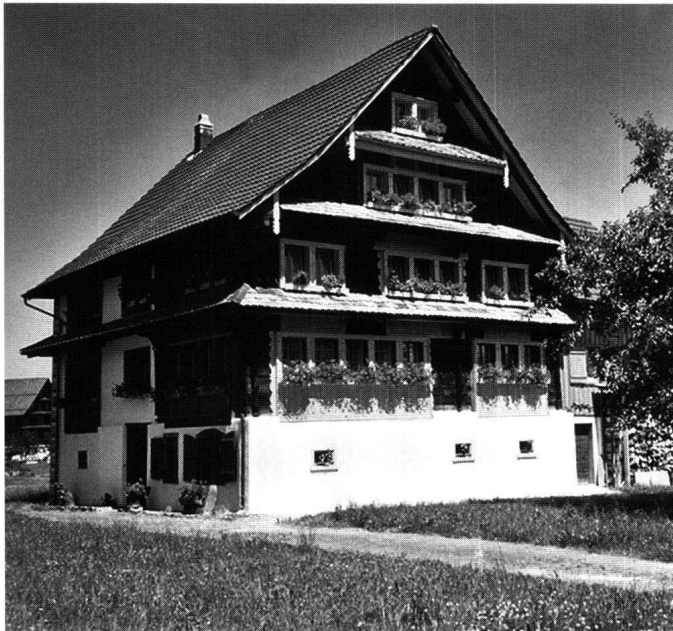
Abb. 19: Schübelbach, Haus Wuhrhof. Die spätbarocken Bauernhäuser der March besitzen meist reich dekorierte Holzfassaden. Die Ziehladenverkleidungen werden von ausgesägten Seitenbärten begleitet und die Ecken der verputzten Rückfronten durch aufgemalte Eckquader betont. Die Fensteranordnung folgt dem Prinzip der Raumeinteilung.
