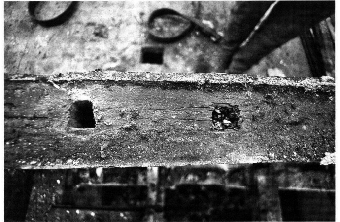
Abb. 37: Aufsicht auf einen Blockbalken mit dem quadratischen Negativ eines Dübels sowie zwei sich überlagernden, abgebrochenen Holzdübeln (Fundsituation).
