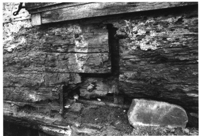
Abb. 3: Nordfassade. Der Block der sekundären Laubenkammer 1.3 (rechts) wurde durch Nut und Kamm mit den ursprünglichen Bauteilen verbunden.
