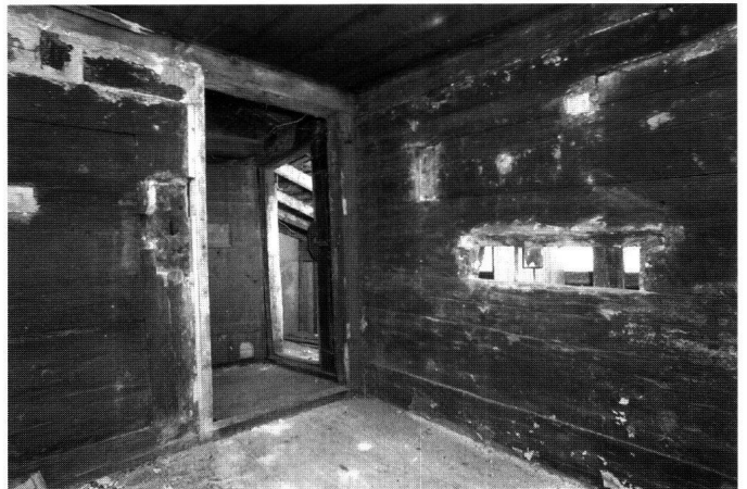
Abb. 26: Obergeschoss, Südwestecke von Raum 2.5.
