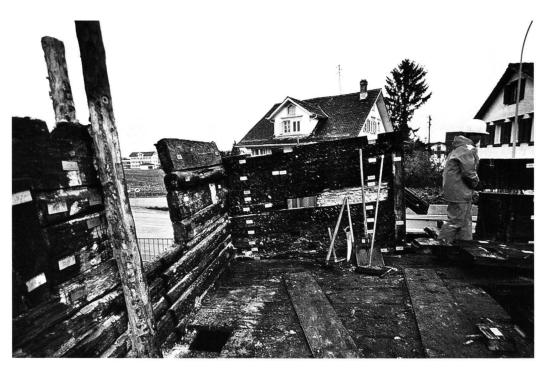
Abb. 44: Das Haus Nideröst beim Abbau im November 2001: Obergeschoss gegen Westen, links eine der beiden Blockzangen.
