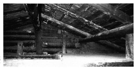
Abb. 15: Giebel der Südwand. Links und rechts des Firstständers sind die Innenwandhölzer der beiden Blockzangen zu erkennen.
