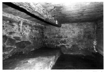
Abb. 29: Untergeschoss, Raum 0.2: Ansicht gegen Südwesten (Wände mit dem angetroffenen Verputz).
