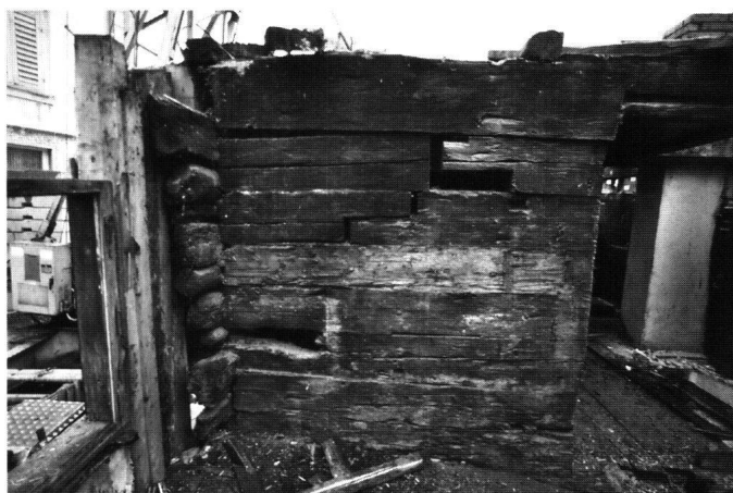
Abb. 6: Ostfassade und Südostecke des Kernbaus im Obergeschoss gegen Westen.
