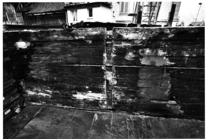
Abb. 39: Mittlere Trennwand des Hauses, Obergeschoss: Negativ der ehemaligen Blockwand zwischen den Räumen 2.9 und 2.10, Ansicht gegen Süden.
