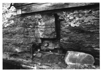
Abb. 3: Nordfassade. Der Block der sekundären Laubenkammer 1.3 (rechts) wurde durch Nut und Kamm mit den ursprünglichen Bauteilen verbunden.
