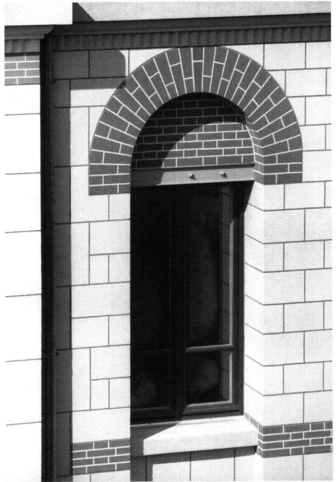
Abb. 17: Küssnacht, Gymnasium Immensee, «Z-Bau», Fassadensanierung. Bei den hellen Quadern ist der Grundputz dunkel, bei den ziegelroten Quadern hell eingefärbt. Gut zu erkennen sind der metallene Fenstersturz sowie die rot lasierten originalen Fenster.
