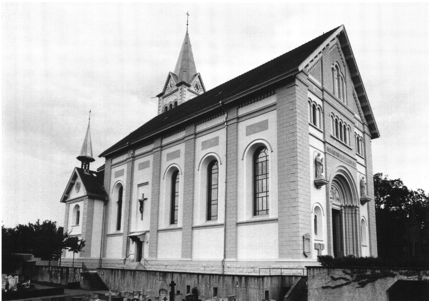
Abb. 18: Reichenburg, Pfarrkirche St. Laurentius. Die 1962 zerstörte Fassadengliederung des 19. Jahrhunderts wurde anhand des Befundes wiederhergestellt.
