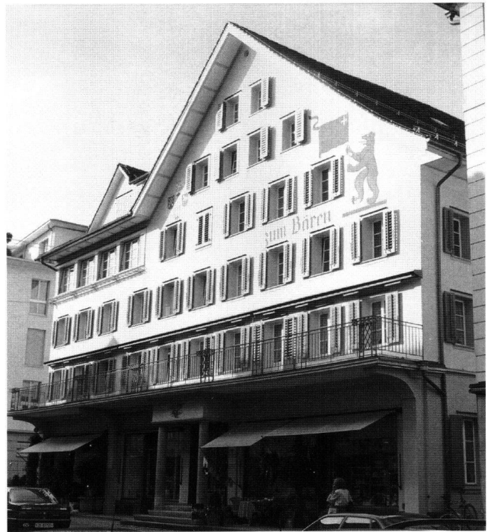
Abb. 6: Schwyz, Bären. An der strassenseitigen Fassade ist der Kernbau mit dem hohen gemauerten Sockelgeschoss gut ablesbar.
