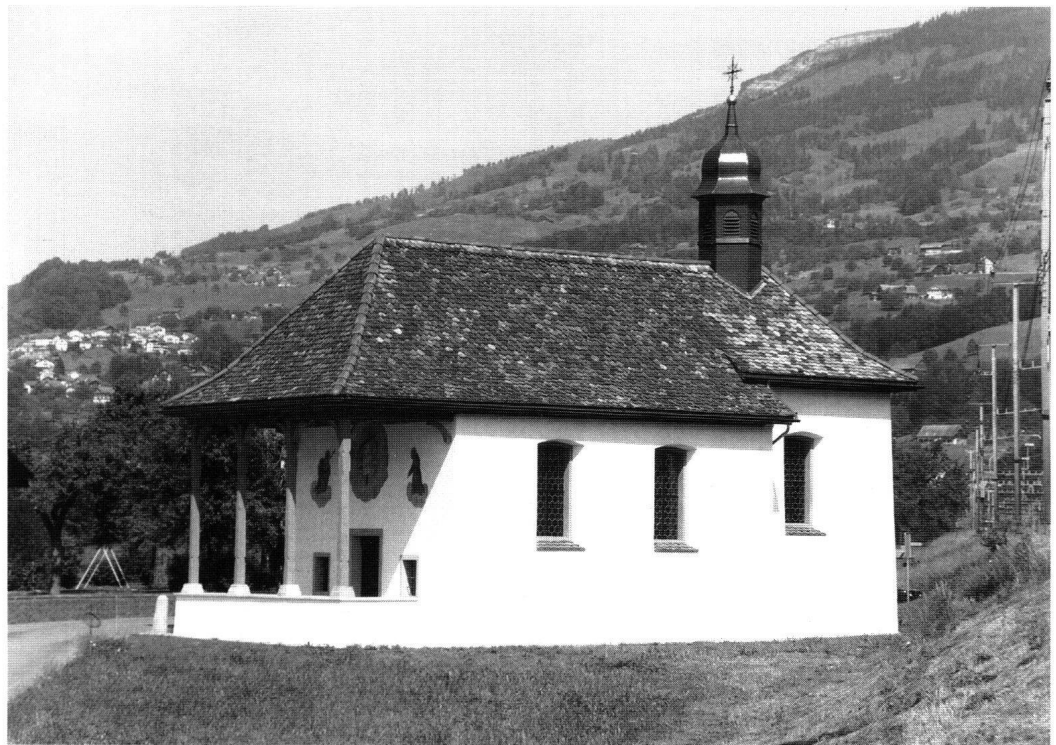
Abb. 9: Steinen, Kapelle zum Grossen Herrgott. Das unter dem gleichen First wie Chor und Schiff integrierte Vorzeichen ist typisch für die Kapellen im 17. und frühen 18. Jahrhundert in der Innerschweiz.
