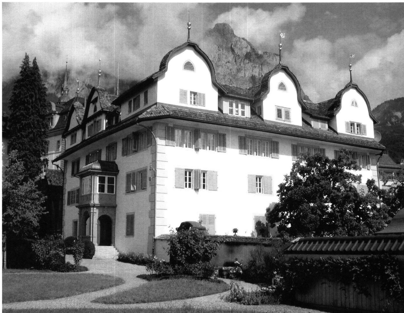
Abb. 5: Schwyz, Reding-Haus an der Schmiedgasse. Blick vom Landschaftsgarten auf die Süd- und Westfassade des Herrenhauses mit dem 1892 vorgebauten Erker.
