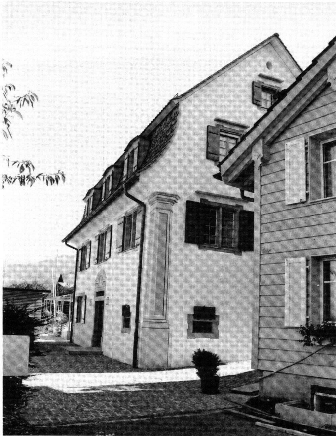
Abb. 15: Altendorf, Serafinahaus. Die Fassaden nach der Wiederherstellung der Architekturbemalung.
