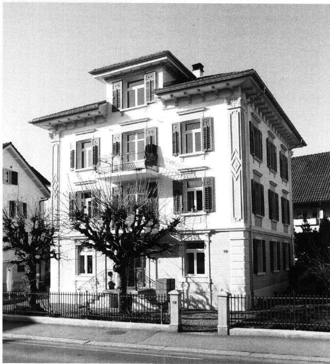
Abb. 13: Steinen, Haus Bahnhofstrasse 8. Das Ende des 19. Jahrhunderts errichtete Gebäude orientiert sich formal und farblich an der italienischen Villenarchitektur.
