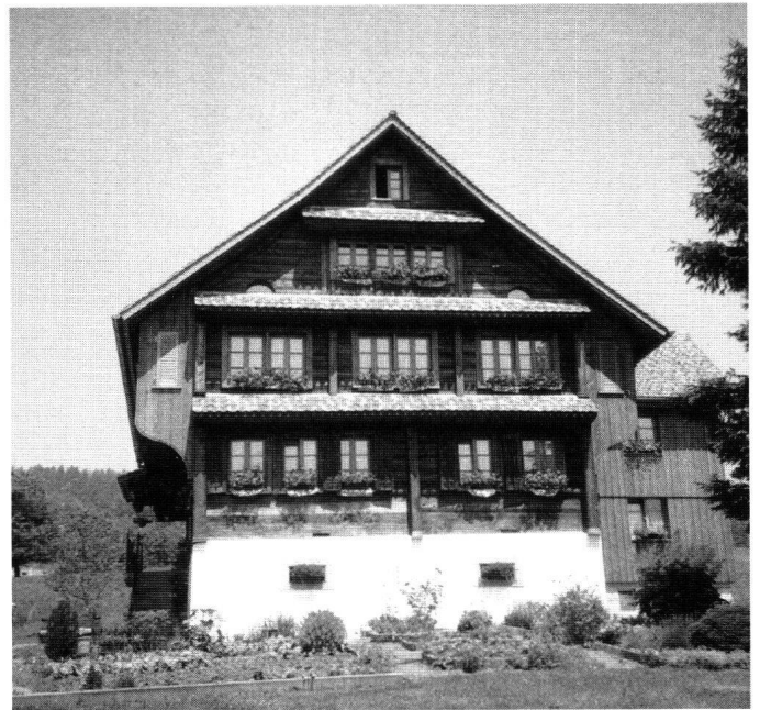
Abb. 17: Tuggen, Haus Holeneich, Bolenbergstrasse 2. Das Bauernhaus des 16. Jahrhunderts wurde in der zweiten Hälfte des 18. Jahrhunderts umgebaut und dabei die Fensteranordnung verändert.
