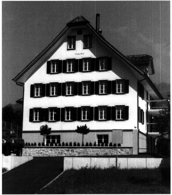
Abb. 14: Schwyz, Haus Schnüriger. Das heutige Erscheinungsbild als verputztes Holzhaus stammt aus dem späten 18. Jahrhundert. Dahinter versteckt sich jedoch Bausubstanz, die bis ins 16. Jahrhundert zurückreicht.
