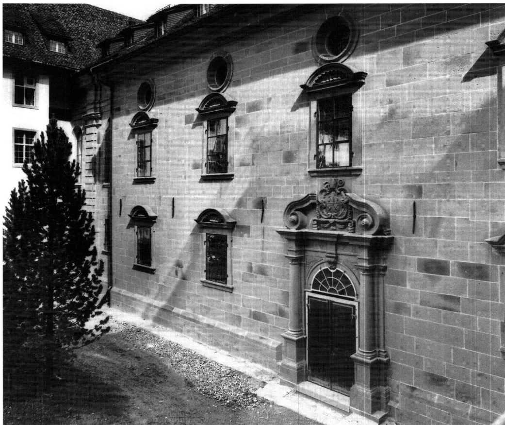
Abb. 25: Einsiedeln, Beichtkirche. Die Westfassade der Beichtkirche war bis zum Bau des neuen Klosters vom Platz her einzusehen. Deshalb ist diese im Gegensatz zur Ostfassade vollständig in Sandstein ausgeführt. Die untere Fensterreihe rechts gehört zum Beichthaus, die darüberliegende zur Studentenkapelle, und die beiden Fensterreihen links führen in die Magdalenenkapelle.
