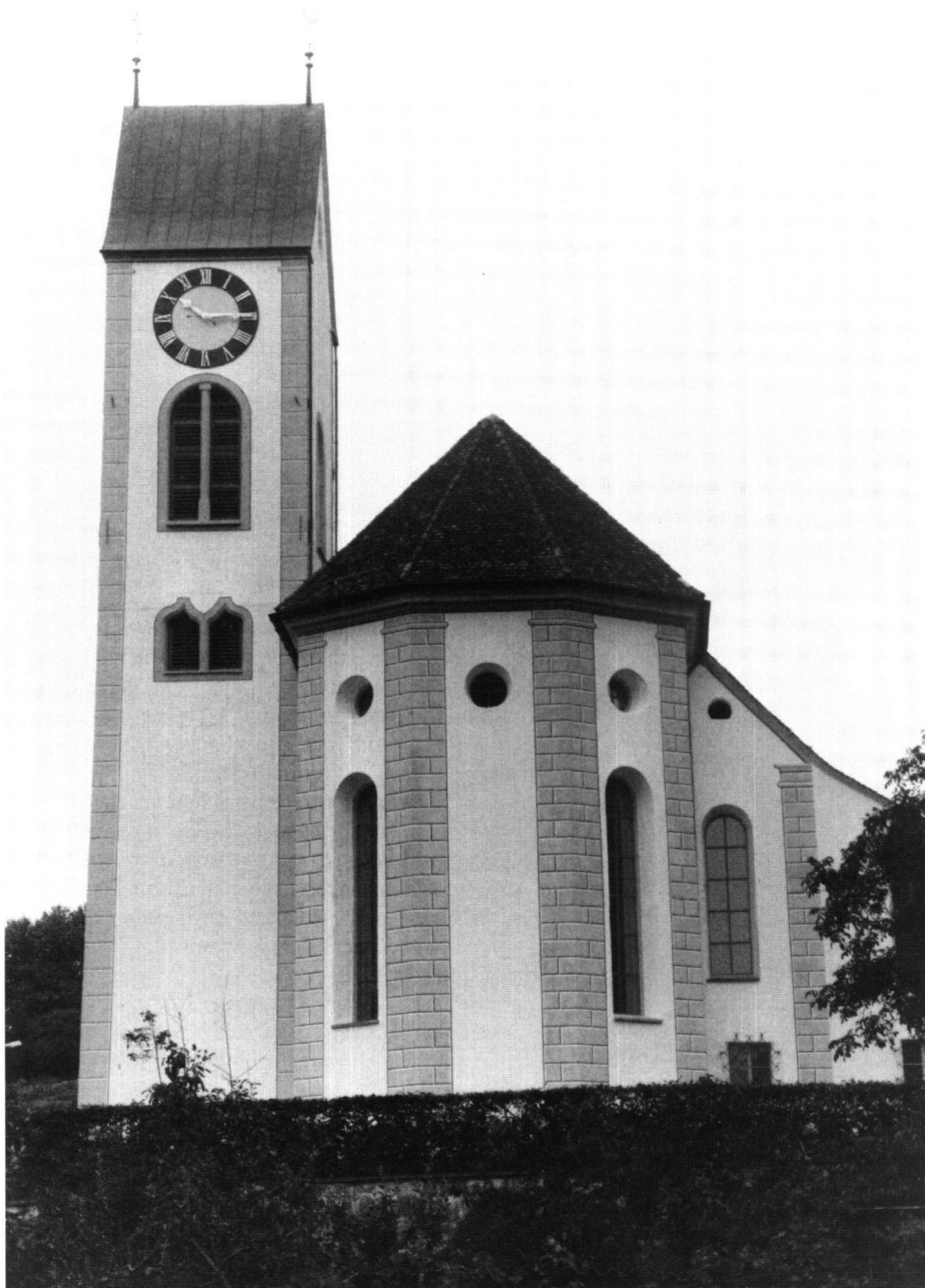
Abb. 23: Tuggen, Pfarrkirche St. Erhard. An den Fassaden des Chores, des Schiffs und am Turm wurde die kräftige Architekturbe- malung anhand des Befundes wiederhergestellt. Die grossflächig original erhaltenen Partien wur- den konserviert und integriert.
