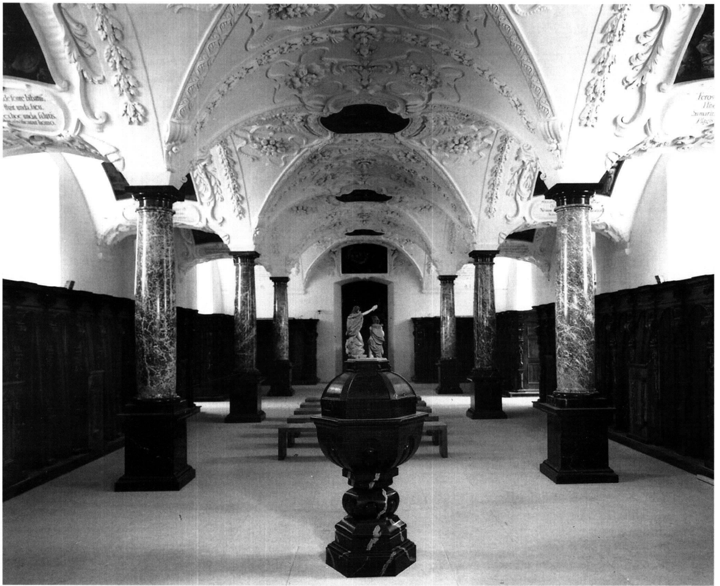
Abb. 26: Einsiedeln, Beichtkirche. Das Beichthaus gegen den Eingang, der zur Kirche führt. Die schwarzen Postamente wurden anlässlich des Tieferlegens des Bodens im Jahr 1901 unter die grauen Säulen gesetzt. Gleichzeitig wurden die vorher einzeln stehenden Beichtstühle zu Reihen zusammengefasst.
