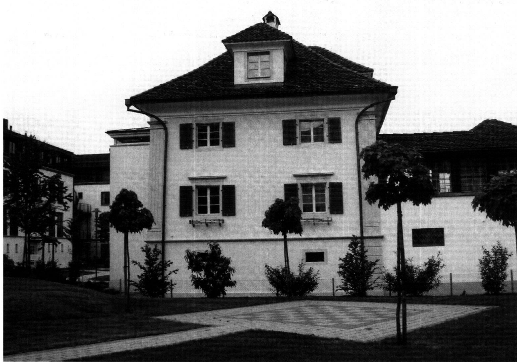
Abb. 31: Küssnacht, Haus Holzgang, Seeplatz 4. Das spätbarocke Bürgerhaus wurde zu Beginn des 20. Jahrhunderts durch aufgesetzte Pilaster und Fensterbekrönungen in Kunststein bereichert. Die barocke Gesamtform blieb dabei jedoch erhalten.
