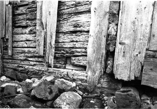
Abb. 23: Ostfassade, Detail: mit modernen Vierkanthölzern verschlossene Negative je eines Einzelvorstosses und von Deckenbohlen einer ehemaligen Nordostkammer im 1. Wohngeschoss.
