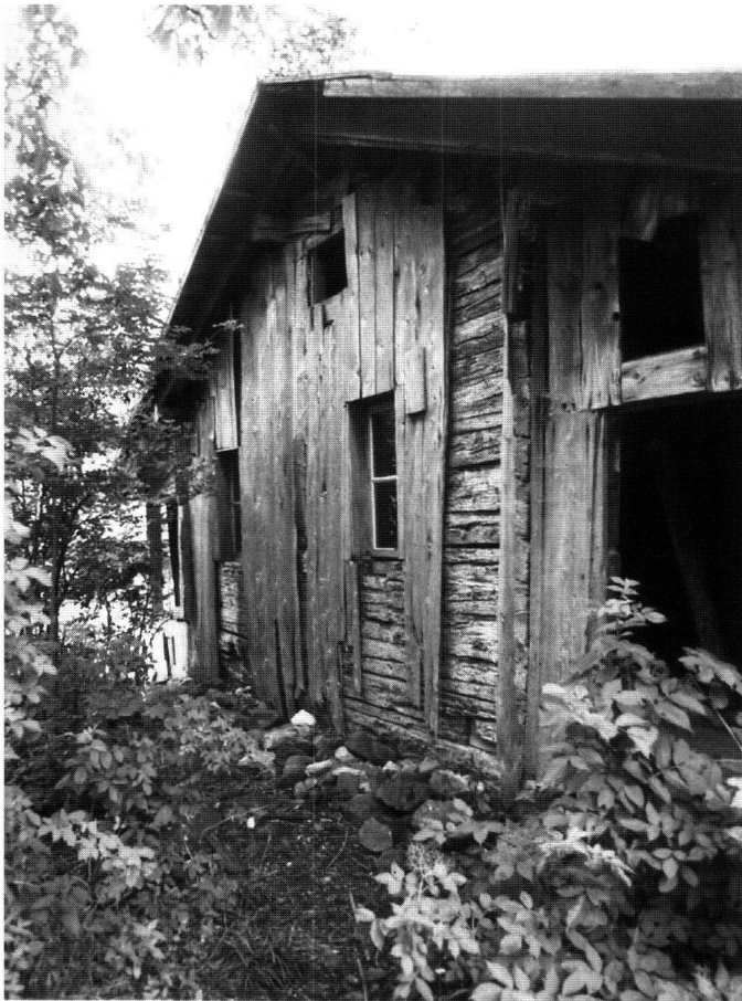
Abb. 22: Ansicht der Ostfassade, gegen Südwesten.
