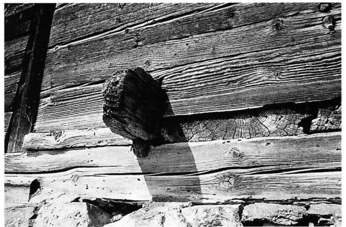
Abb. 15: Westfassade gegen Nordosten. Einzelvorstoss einer Zwischenwand und fassadenbündige Decken-Boden-Bohlen
