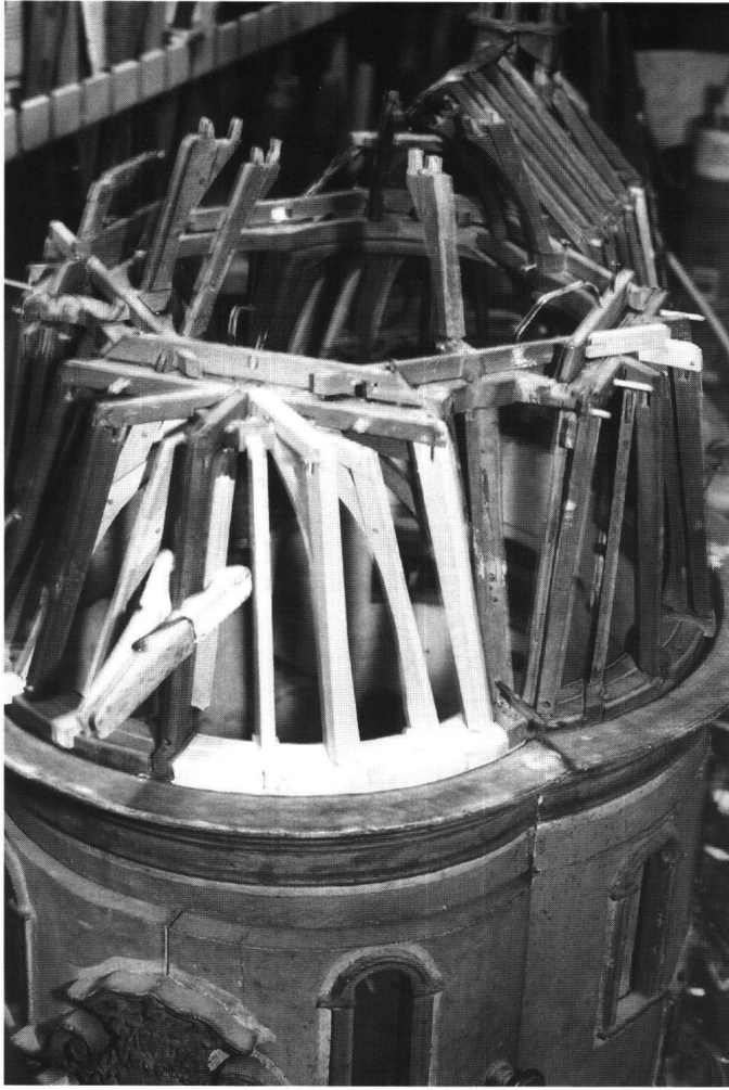
Abb. 3: Der Dachstuhl während des Wiederaufbaus. Die ergänzten Teile sind aus naturfarbig belassenem Lindenhholz geschnitzt und mit Holzzäpfchen befestigt.
