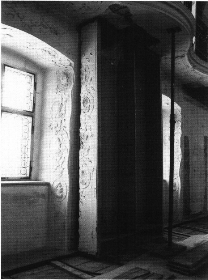
Abb. 15: Einsiedeln, Kloster, Bibliothek. Ein an den originalen Standort zurückversetztes Büchergestell. Gut zu erkennen sind die Beschädigungen an der Seitenwand des Gestells sowie an der Untersicht der Galerie.
