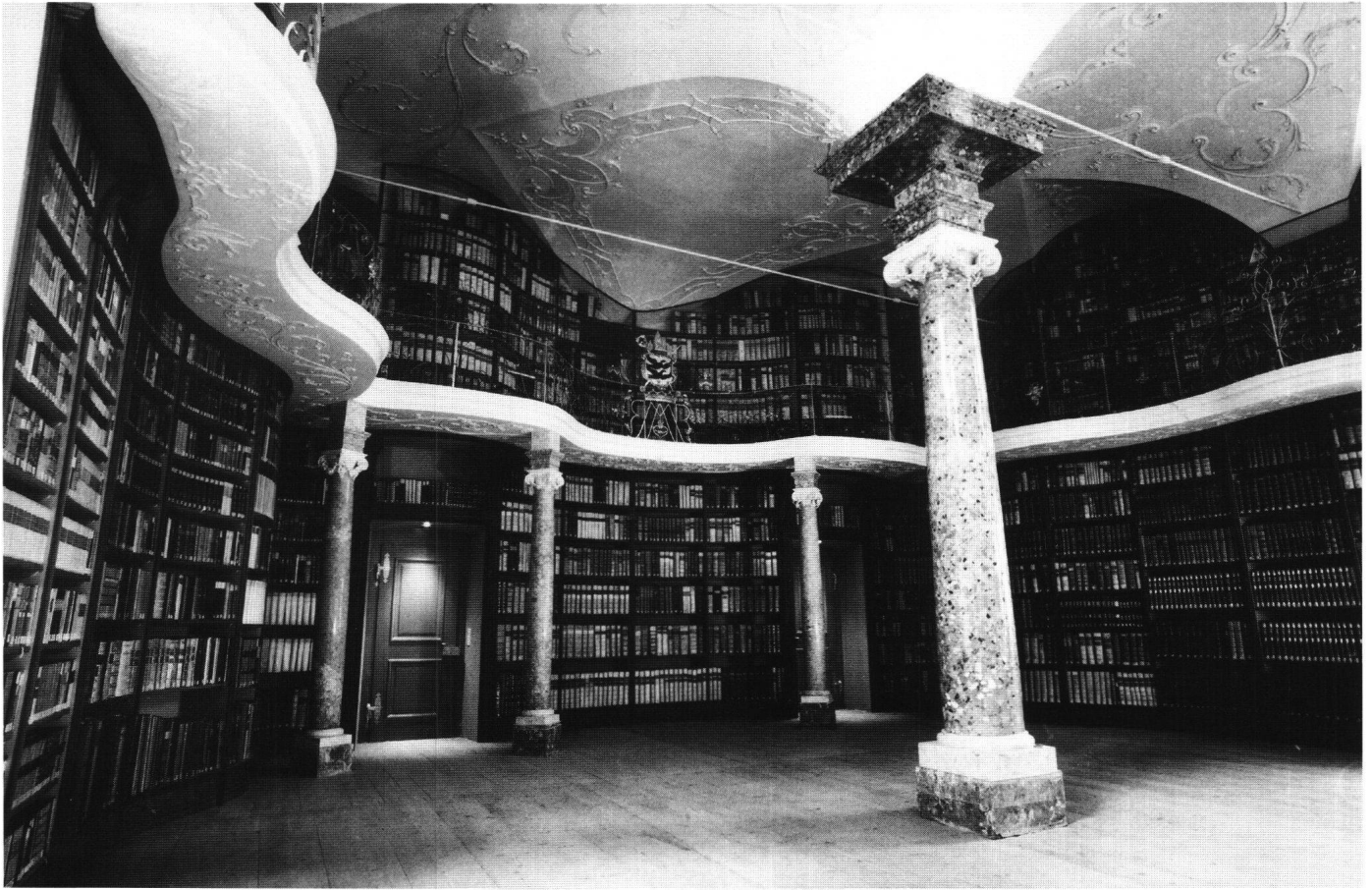
Abb.12: Einsiedeln, Kloster, Bibliothek. Blick gegen die Rückwand der Bibliothek nach der Restaurierung. Die Büchergestelle des Galeriegeschosses sind ca. zur Hälfte original. Vollständig rekonstruiert sind die im Bild sichtbaren Teile der Gestelle unterhalb der Galerie.
