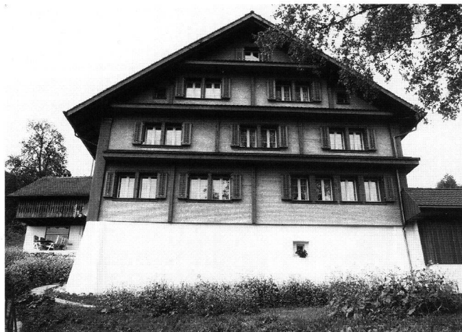
Abb. 3: Schwyz, Engiberg, Haus Kündig. Im Kern des grossen Bauernhauses versteckt sich ein älterer Bau aus dem 18. Jahrhundert. Dieser ist aussen an den Reihenfensern im rechten (östlichen) Hausteil zu erkennen. Deutlich sind die Eckverstärkungen im Mauersockel zu sehen, die im Rahmen der Hauserweiterung im 19. Jahrhundert vorgemauert worden sind.
