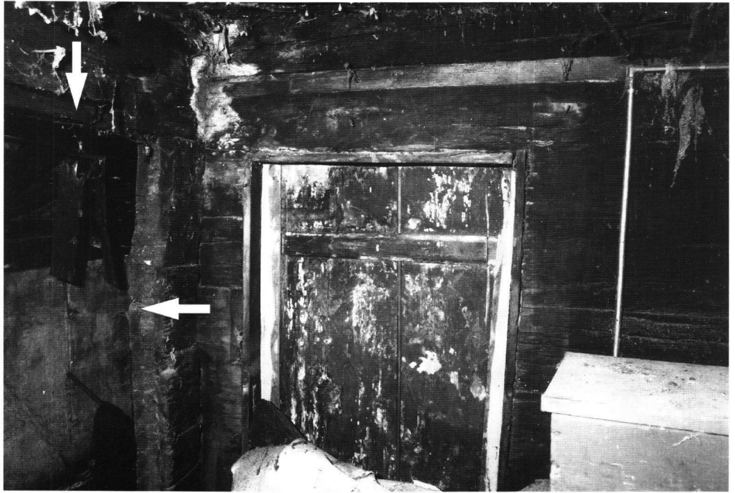
Abb. 18: Zweites Obergeschoss. Rechts im Bild Trennwand mit einer sekundären Tür, links Spuren und Reste eines originalen Ausganges auf die Nordlaube (Aufnahme 1997).
