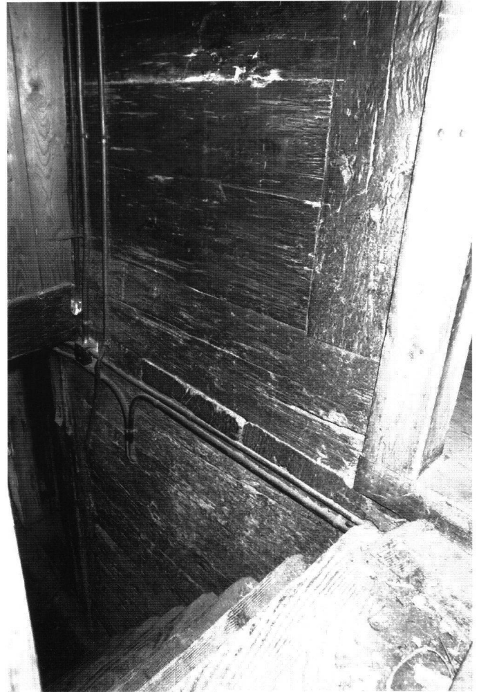
Abb. 16: Zweites Obergeschoss, Trennwand. Erkennbar sind Decken-/Bodenbohlen sowie ein ursprünglicher Türpfosten (Aufnahme 1997).
