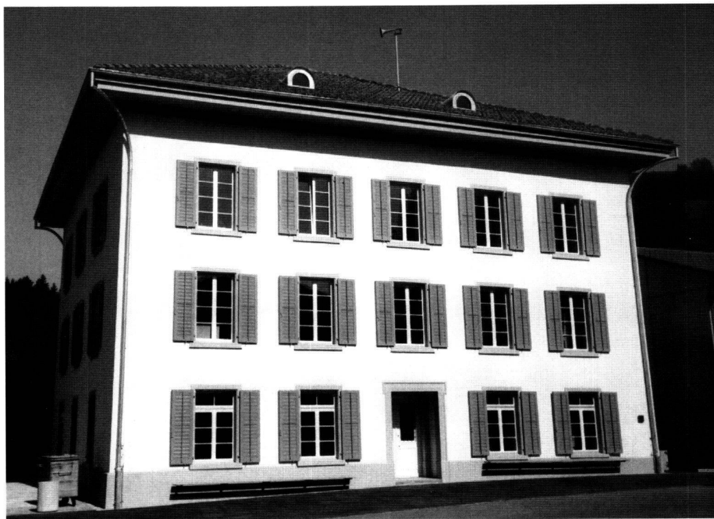
Abb. 31: Einsiedeln: Schulhaus Egg. Das alte Schulhaus ist neben der Kirche der markanteste Baukörper im Dorfbild von Egg. Der rauhe Besenwurf gehört zur alten Substanz.
