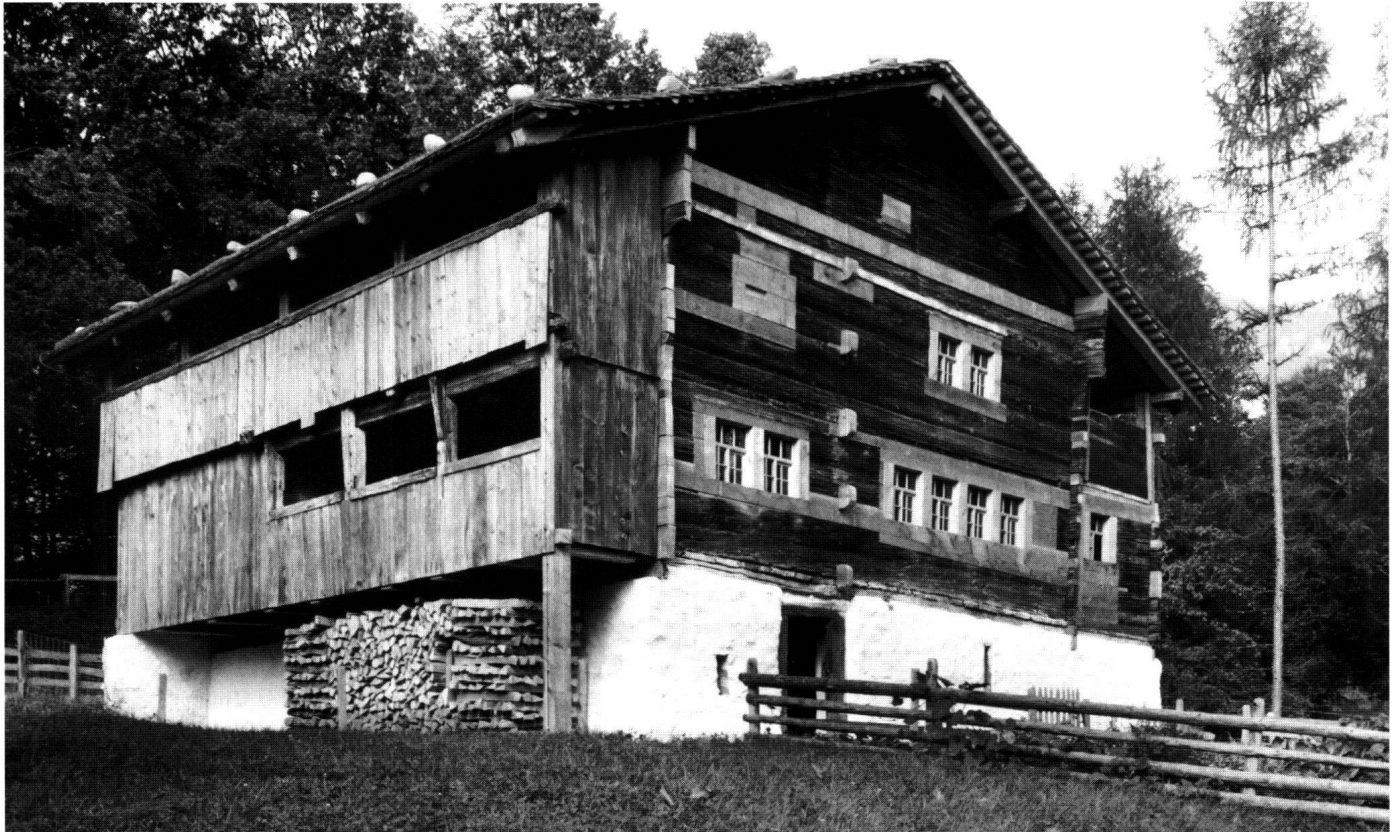
Abb. 5: Schwyz: Haus am Landsgemeindeplatz, Hinteribach – heute im Freilichtmuseum Ballenberg. Im Gegensatz zur Rückfront ist die Südfront wesentlich besser belichtet. Einzig der kleinere Schlafraum im Obergeschoss besitzt lediglich eine Lüftungsluke.
