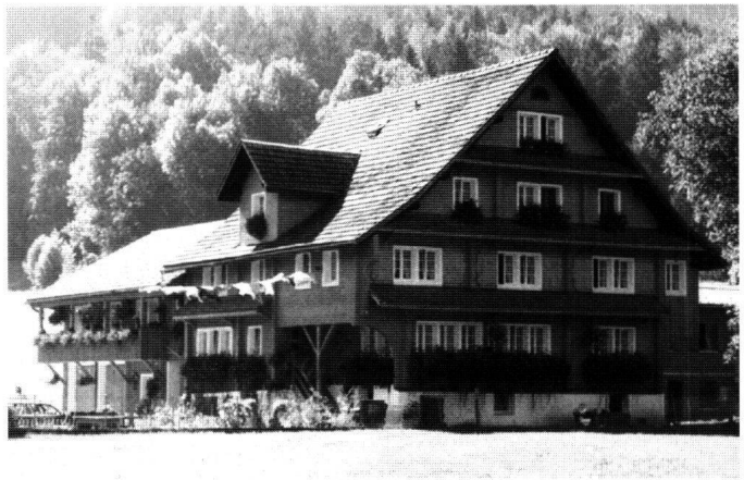
Abb. 15: Muotathal: Haus Lustnau, Ried. Das Bauernhaus in der Lustnau besteht aus einem Kernbau, vermutlich aus dem 18. Jahrhundert, und einer Erweiterung im Dachbereich aus dem 19. Jahrhundert. Diese bauliche Entwicklung ist besonders gut an der Fenstereinteilung der Hauptfassade abzulesen.
