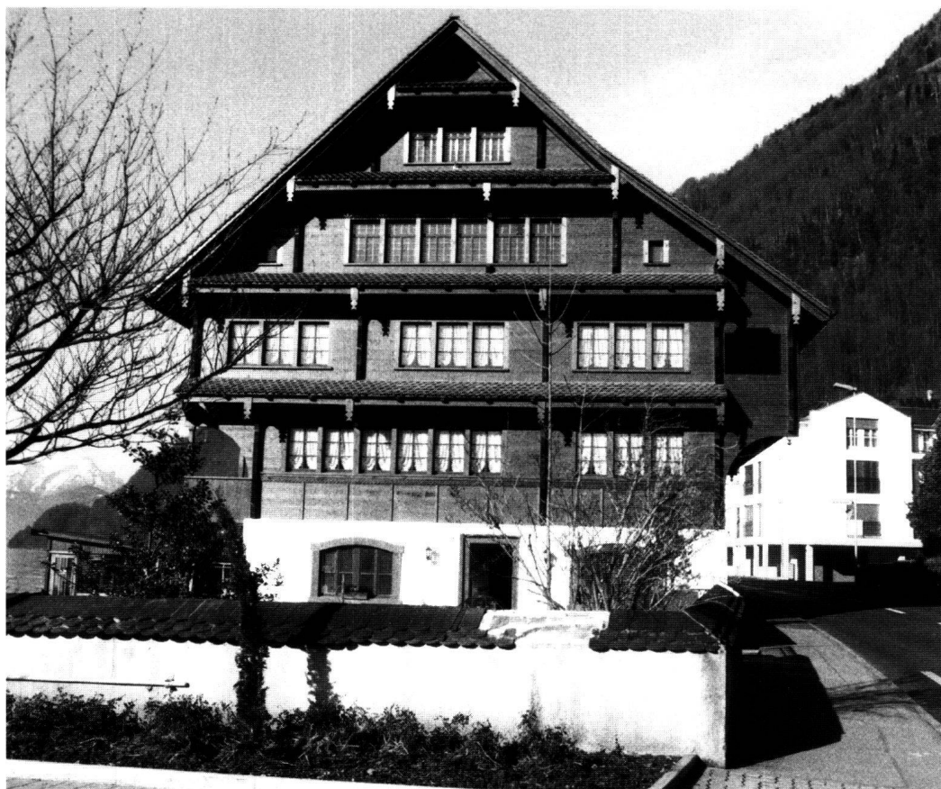
Abb. 19: Gersau: Haus Gerbi. Nach dem Brand von 1994 wurde der wuchtige Baukörper anhand photogrammetrischer Aufnahmen wiederhergestellt.
