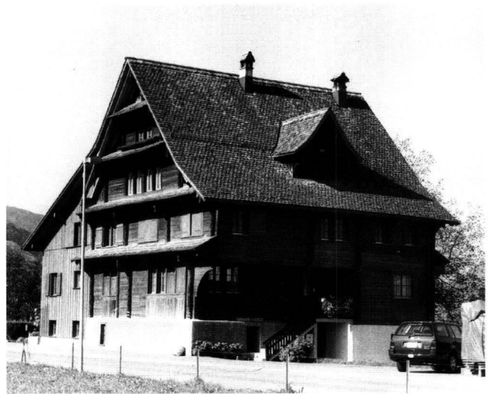
Abb. 10: Schwyz: Haus Steiner, Ibach. Das 1677 datierte Bauernhaus gehört zu den grossen, markanten Holzhäusern des Alten Landes Schwyz. Für die Erbauungszeit besitzt es insbesondere in den oberen Geschossen eine moderne Fenstereinteilung.
