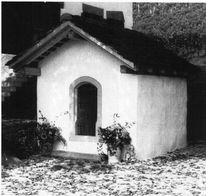
Abb. 19: Freienbach, Wegkapelle Breitenstrasse, Wilen. Beim Wiederaufbau der einfachen Wegkapelle im 18. Jahrhundert wurden ältere Bauteile übernommen. Bei der jetzigen Restaurierung musste der Dachstuhl vollständig ersetzt werden.
