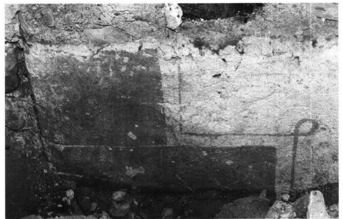
Abb. 9: Galgenen, Haus Kürzi. Gemalte Eckquader am Hauptbau, die durch den Saalanbau von 1597 verdeckt worden sind. Diese sind u. a. ein Beleg dafür, dass der Saalanbau jünger ist als der Hauptbau.
