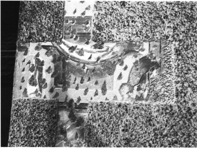
Abb. 8: Altendorf, Krone, Seestatt. Die freigelegte Architekturbemalung zeigt zahlreiche Hackspuren, die zur besseren Haftung des groben Besenwurfes angebracht worden sind.
