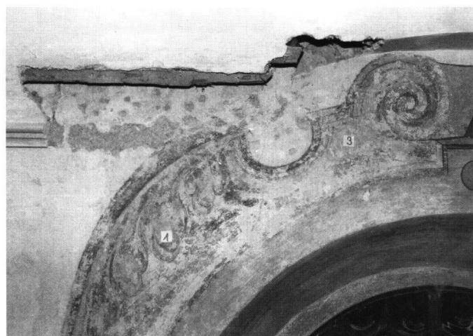
Abb. 13: Einsiedeln, Friedhofskapelle. Die von den Übermalungen befreiten Dekorationsmalereien bei den Fenstern im Kirchenschiff vor den Farbretochen. Am oberen Bildrand ist deutlich zu sehen, dass der zur Malschicht gehörende Verputz hinter der um 1800 eingezogenen Gipsdecke weitergeht.
