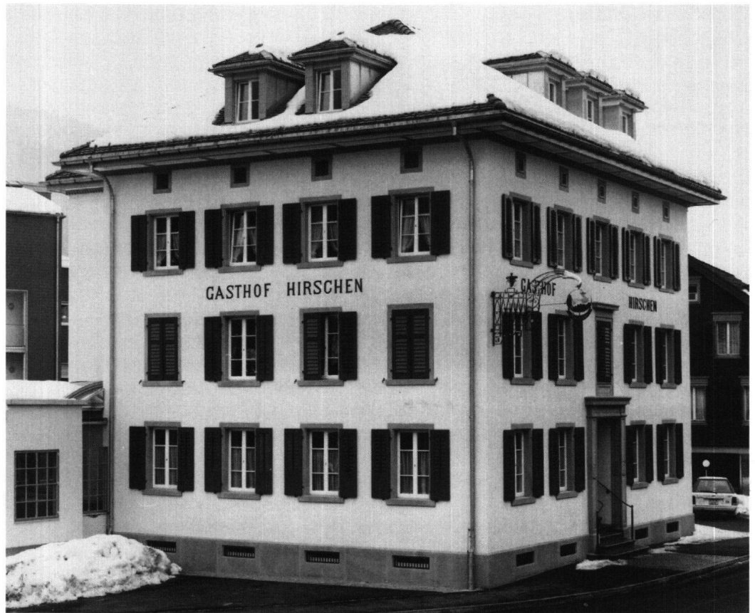
Abb. 21: Feusisberg, Gasthaus Hirschen, Schindellegi. Das streng gegliederte Gebäude bildet den markanten Eckpunkt. Aufgelockert werden die Fassaden durch das zwischen zweitem Obergeschoss und kassettierter Dachuntersicht eingeschobene Mezzaningeschoss.
