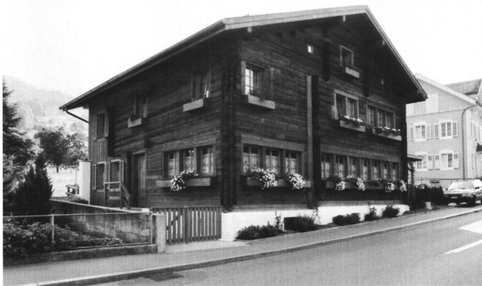
Abb. 9: Steinen, Haus Schürmann, Schwyzerstrasse 9. Das Gebäude präsentiert sich heute in der Kombination des Kernbaus aus dem 13. Jahrhundert und dem westseitigen Anbau aus dem 18. Jahrhundert. Rückseitig sind die Neubauteile in Ständerkonstruktion zu erkennen.
