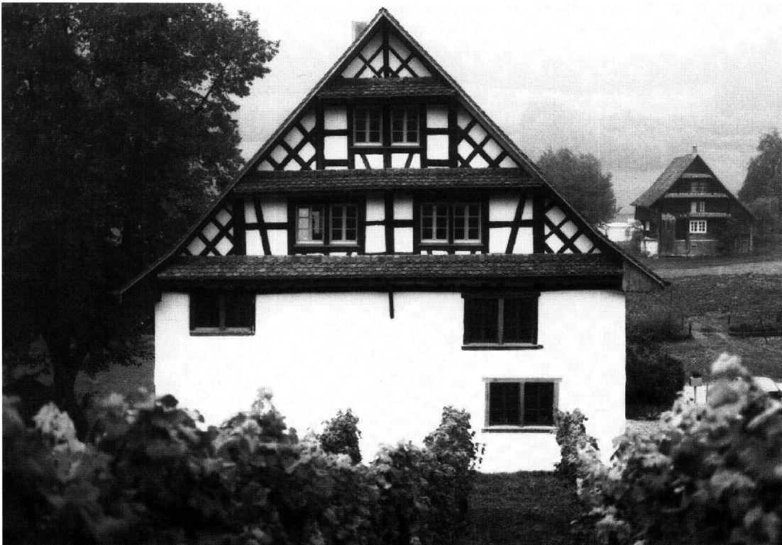
Abb. 28: Freienbach, Haus Breitenstrasse 100. Der bergseitige Massivbau ist 1544 datiert. Der in Fachwerkkonstruktion ausgeführte Dachgiebel mit den vorgehängten Klebdächern gehört zur Umbauphase des 18. Jahrhunderts.
