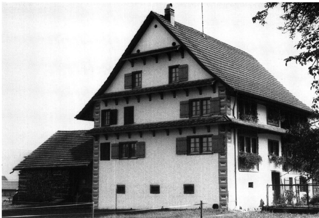
Abb. 24: Schübelbach, Haus Dobler. Die massive Westmauer ist für die Märcbler Bauernhäuser aus dem späten 18. und frühen 19. Jahrhundert typisch. Original erhaltene Eckquaderbemalungen sind aber eher selten.
