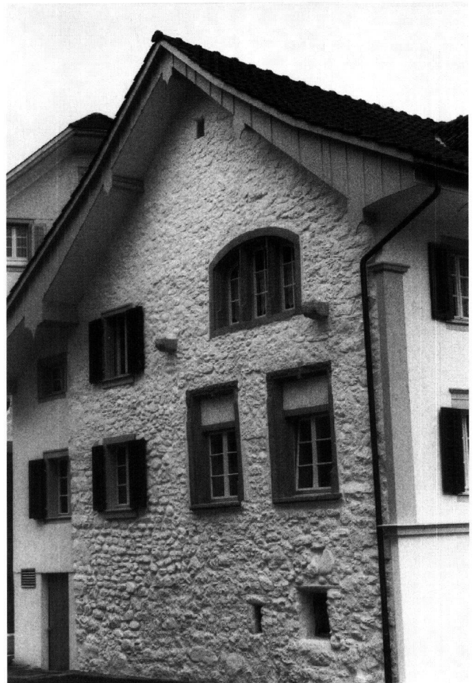
Abb. 15: Steinen, Krone. Auf der Nordseite der Krone konnte der ehemalige Turm mit den jüngeren Fenstern des 15. Jahrhunderts sichtbar gemacht werden, ohne die Einheit des Gebäudes zu stören.
