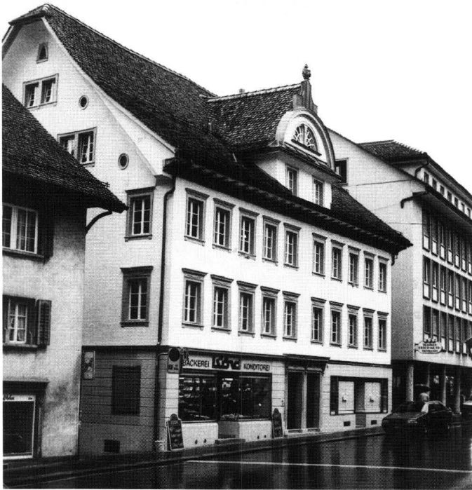
Abb. 6: Schwyz, Haus Gensch/Weber. Das markante Doppelhaus zeigt heute das Gesicht des frühen 19. Jahrhunderts. Dominant ist der klassizistische Dachaufbau auf der Herrengasseite.
