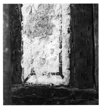
Abb. 7: Schwyz, Haus Gemsch/Weber. Ausschnitt aus der Fachwerkkonstruktion mit rot gefasstem Holzwerk, weissen Gefachen und dunklen Begleitlinien.
