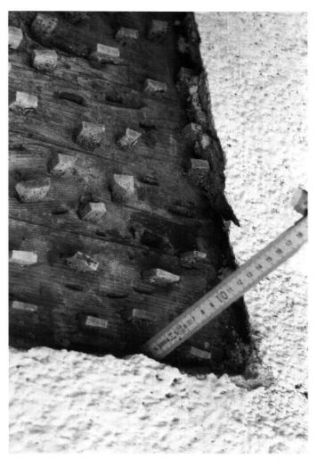
Abb. 4: Schwyz, Haus Appert. Detail der Fassade. Mittels Holznägel wurde der Putz auf den Holzbalken stabilisiert.
