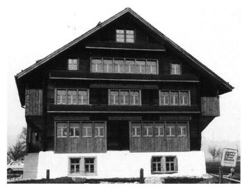
Abb. 21: Schübelbach, Haus Ziegler: Die Fassaden des 1596 erbauten Hauses wurden im 18. Jahrhundert verändert. Die zu diesem Zeitpunkt vergrösserten Fenster und die vorgehängten Klebdächer wurden in das Restaurierungskonzept miteinbezogen.
