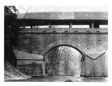
Abb. 28: Einsiedeln, Teufelsbrücke, Egg. Deutlich zu erkennen sind die von Bruder Caspar Natter unter die bestehende Brücke eingespannten Verstärkungsbogen und die vor die alte Konstruktion gestellten Postamente. Vermutlich stammen auch die Verstärkungseisen aus der gleichen Zeit.
