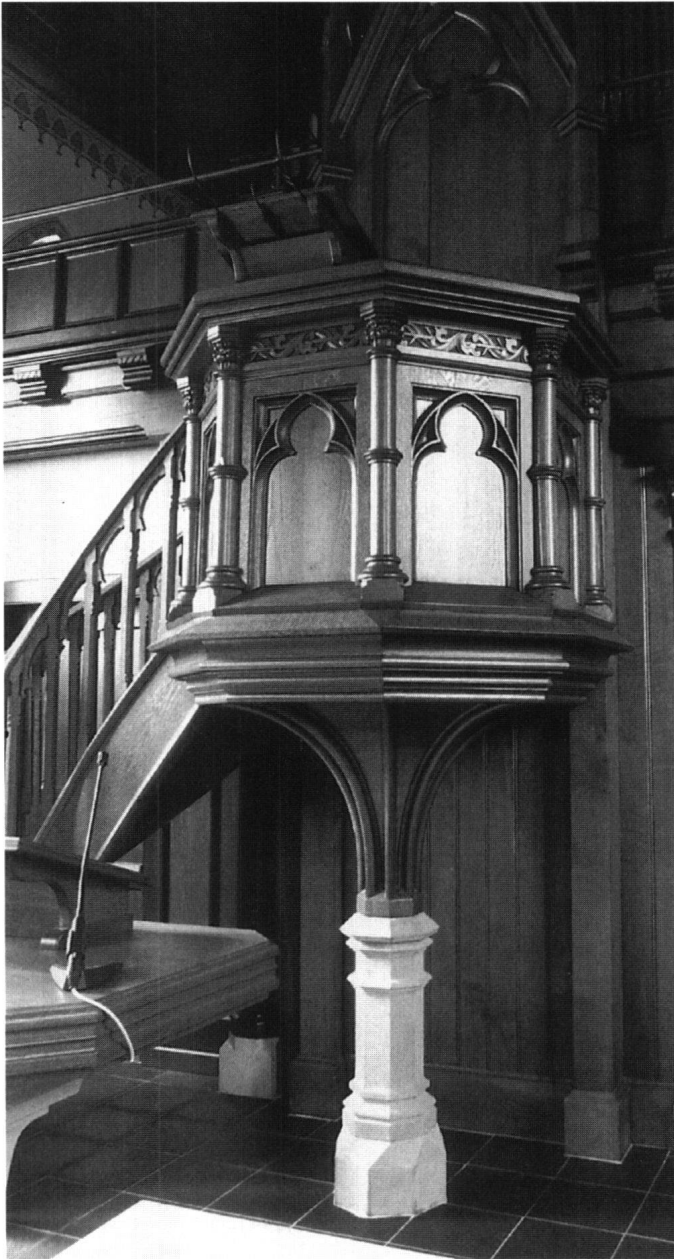
Abb. 8: Arth, reformierte Kirche Oberarth. Die in die Emporenbrüstung integrierte Kanzel wurde lediglich aufpoliert.
