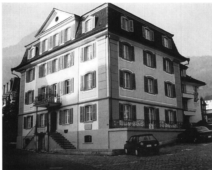
Abb. 15: Gersau, Herrenhaus Hof. Die Fassaden zeigen die wiederhergestellte, teils plastische, teils malerische Gliederung.
