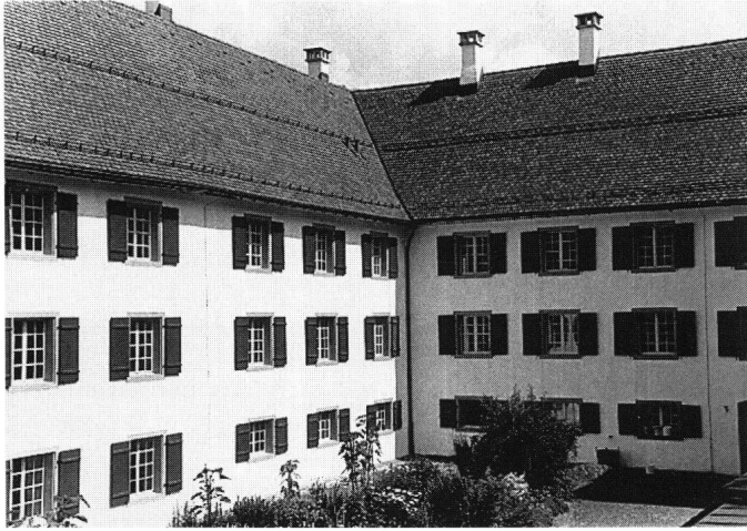
Abb. 22: Einsiedeln, Kloster in der Au, Trachslau. Die restaurierten Fassaden des Nord- und Südflügels des Innenhofs. Der Blitzableiter markiert die Nahtstelle zwischen dem Bau des 17. und dem Anbau des 19. Jahrhunderts.
