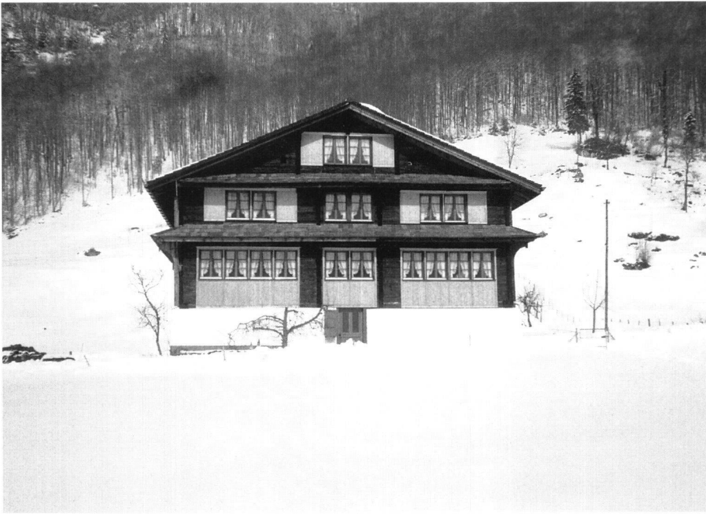
Abb. 12: Muotathal, Haus Boden, Ried. Innerhalb der Streusiedlung Ried besitzt das Haus Gwerder, Boden, einen sehr hohen Stellenwert. Bereits von aussen ist anhand der Fenstereinteilung zu erkennen, dass es als doppelmänniges Haus geplant wurde.
