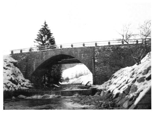
Abb. 13: Ober- / Unteriberg, Jessenenbrücke. Blick auf den flach gespannten Bogen, der von zwei kräftigen Widerlagern gehalten wird.
