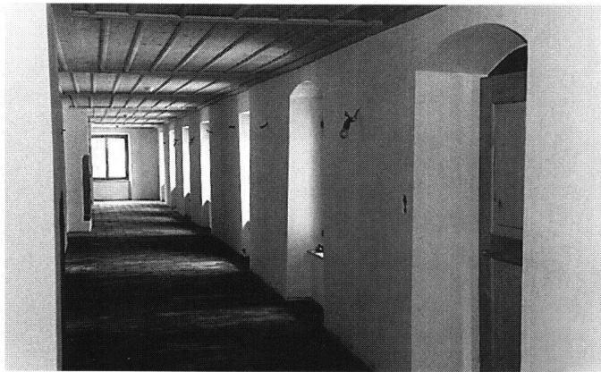
Abb. 23: Einsiedeln, Kloster in der Au, Trachslau. Gang im ersten Obergeschoss. Tonplattenboden und Holzdecke verliehen den Gängen eine architektonische Geschlossenheit. In die Mauervorsprünge links im Bild sind die Feuerstellen für die Kachelöfen eingelassen.
