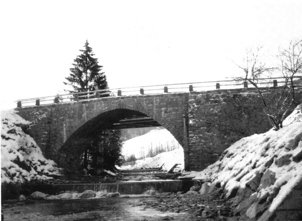
Abb. 13: Ober- / Unteriberg, Jessenbrücke. Blick auf den flach gespannten Bogen, der von zwei kräftigen Widerlagern gehalten wird.
