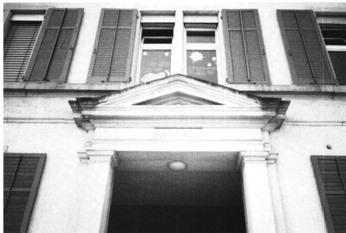
Abb. 1: Portal des Schulhauses Dorfhalde.
