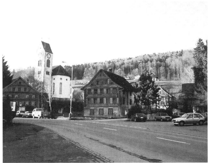
Abb. 2: Erstes Schulhaus kurz vor dem Abbruch 1990.
