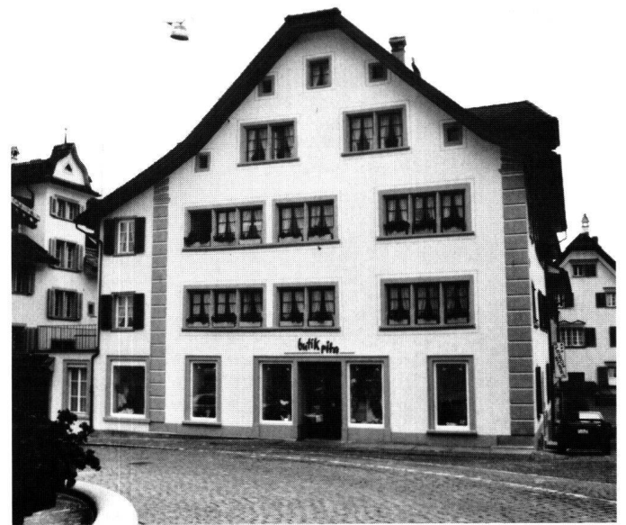
Abbildung 6 Schwyz, Haus Gürber, ehemals Apotheke Triner. Hauptfront nach der Restaurierung mit rekonstruierter Eckquaderbemalung.
