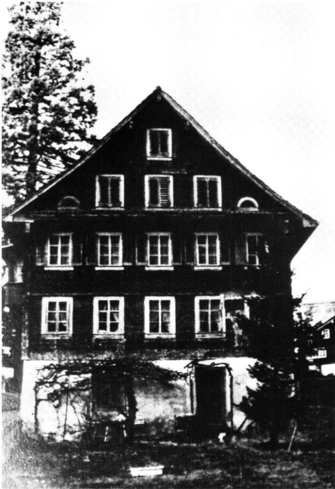
Abbildung 25 Morschach, Pfarrhaus. Die Hauptfront vor der Restaurierung mit regularisierten Fenstern und Schindelmantel.
