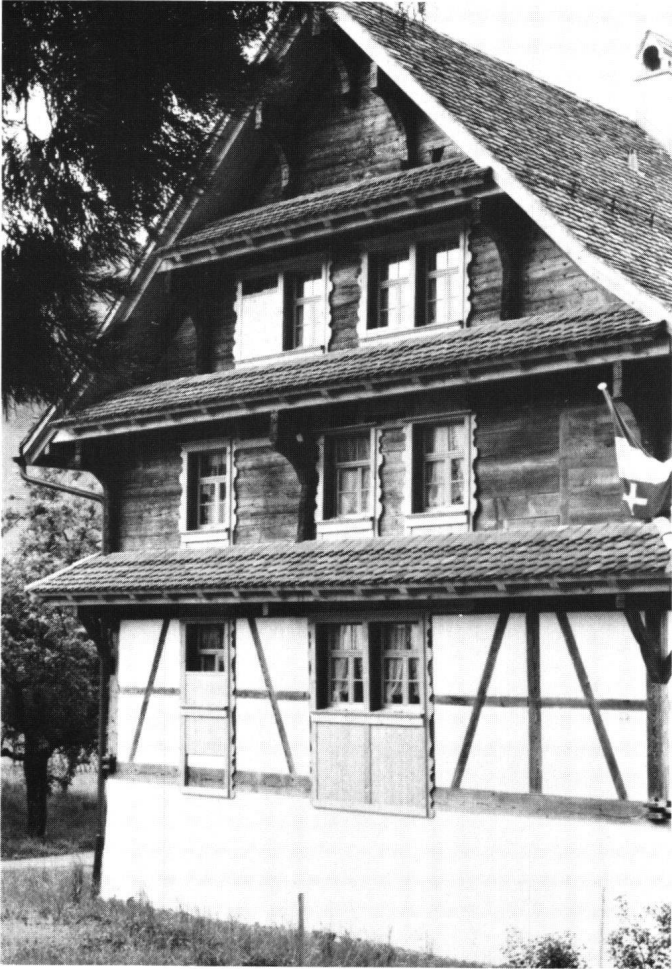
Abbildung 28 Morschach, Pfarrhaus. Die restaurierte Rückfront.
