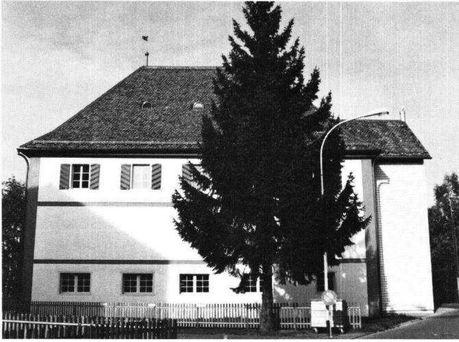
Abbildung 36 Einsiedeln, Chärnehus. Das Äussere nach der Restaurierung mit der wiederhergestellten Fassadenbemalung.
