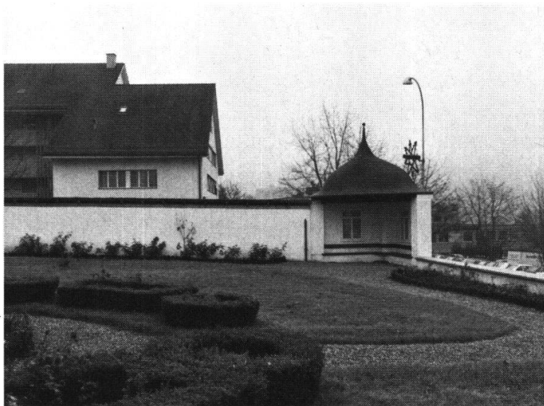
Schwyz, Gartenanlage Reding-Haus an der Schmiedgasse. Zustand nach dem Wiederaufbau der Gartenmauer und des Schattenhäuschens.
