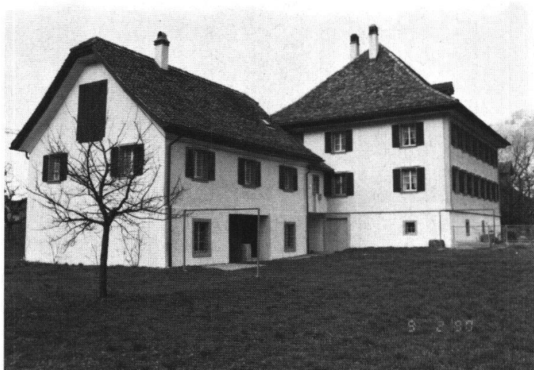
Arth, Georgshof. Der Georgshof besitzt mit seinem herrschaftlichen Aussehen neben der Georgskapelle einen sehr hohen Stellenwert.
