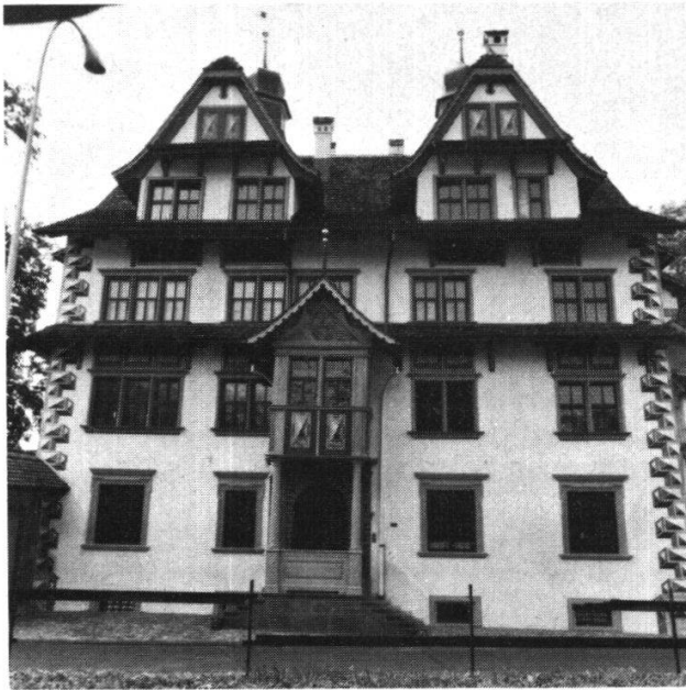
Schwyz, Ital Reding-Haus. Die Nordfassade nach der Restaurierung.
