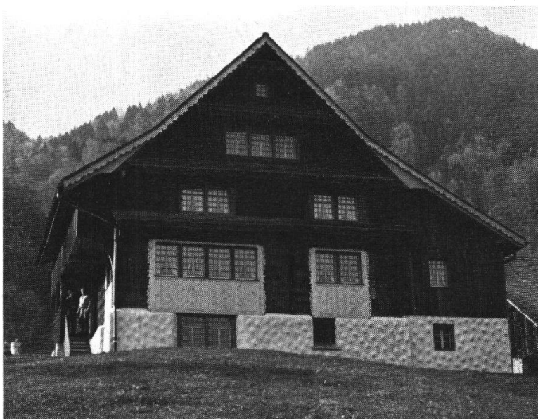
Sattel, Bauernhaus Dietzigen. Zustand nach der Wiederherstellung der Ziehläden. Der gut gemeinte, aber als geschmäckerlich zu bezeichnende Sokkelputz wird korrigiert.
