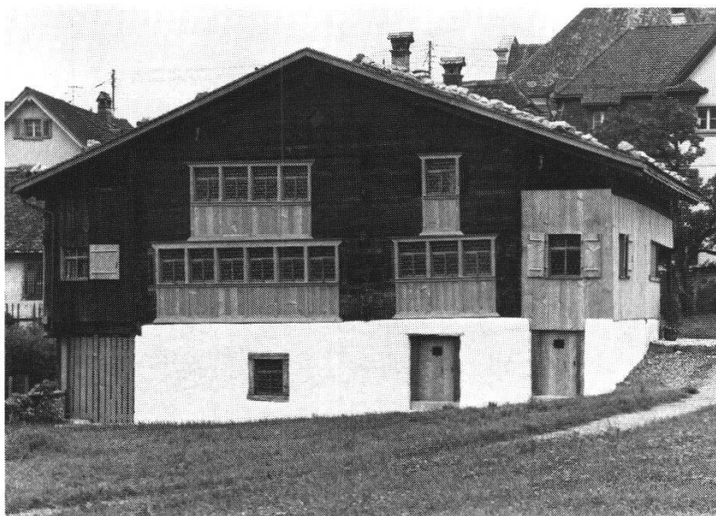
Schwyz, Haus Bethlehem. Die Hauptfront des Bethlehem zeigt die Prinzipien, die für die Restaurierungsmaßnahmen erarbeitet wurden. Das Haus behielt das Aussehen, das es um 1700 erhalten hatte. Die vergrößerten Fenster mit der Putzenverglasung und den Ziehläden sowie die beiden seitlichen Lauben, die gegen Ende des 18. Jahrhunderts in Zimmer umfunktioniert wurden, blieben erhalten.
