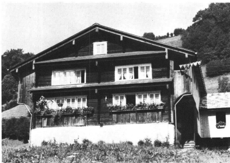
Schwyz, Aufiberg, Bauernhaus Untere Hockern. Das 1768 erbaute Tätschdachhaus ist in seiner ganzen Struktur sehr gut erhalten. Der symmetrische Fassadenaufbau zeigt, daß es als doppelmänniges Haus mit im First geteilter Nutzung erbaut wurde.
