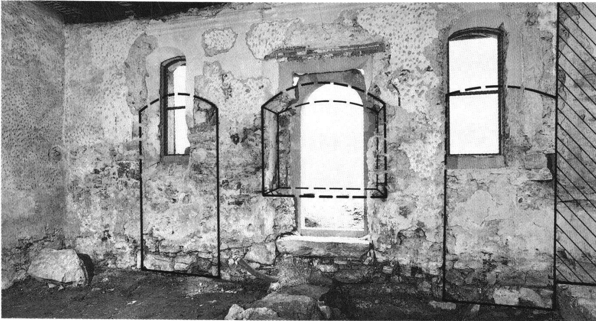
Abbildung 4 Nordwand des Schiffes zur Zeit der archäologischen Untersuchungen. Eingezeichnet sind die festgestellten Baufugen (ausgezogene Linien) der beiden Eingänge und des Seelfensters. Die gestrichelten Linien sind ergänzende Rekonstruktionen. Rechts im Bild (schraffiert) der vermauerte Ausriß der nördlichen Chorschulterwand (Foto Fibbi-Aeppli).
