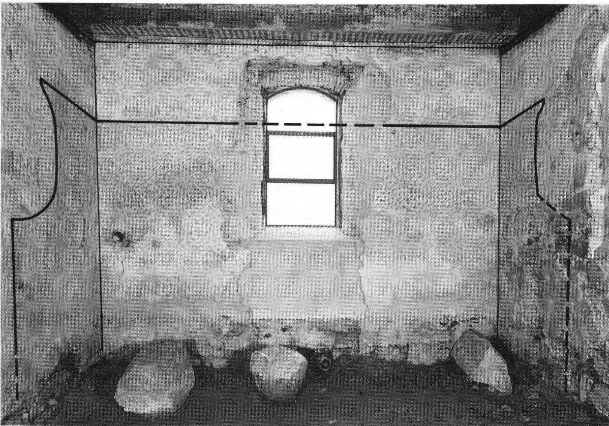
Abbildung 5 Westwand des Schiffes zur Zeit der archäologischen Untersuchungen. Ausgezogen sind die Grenzen von festgestellten Verschmutzungen, die von den bis 1828 im Beinhaus aufgeschichteten Gebeinen herrühren. Die Umgrenzungen geben die Form der ehemaligen Totengatter wieder. Die Steinblöcke sind 1828 eingetragen worden und dienten als Auflager des damals aufgehöhten Fußbodens. Das sichtbare Fenster war lediglich ein Provisorium während der jüngsten Restaurierung (Foto Fibbi-Aeppli).
