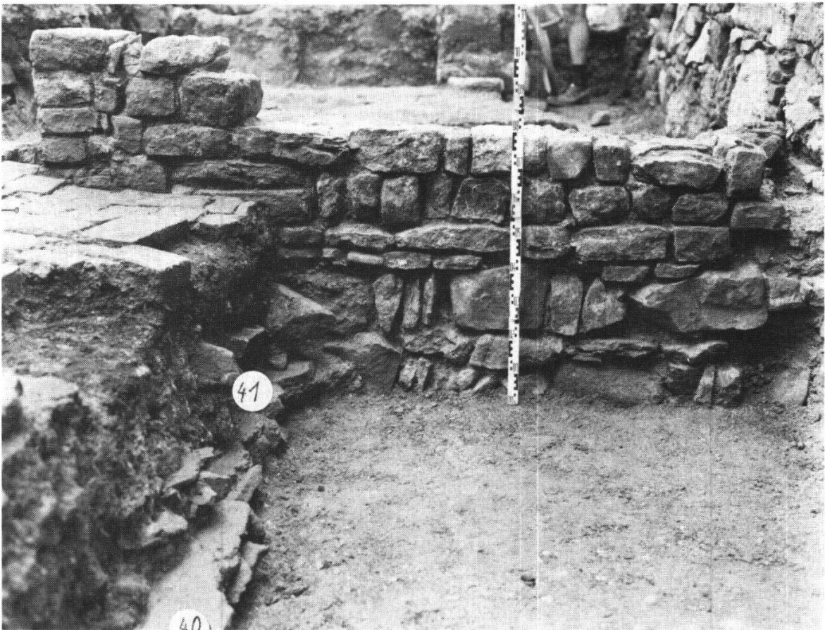
Abbildung 16: Detail der romanischen Mauer 38 Nord (aufgehendes Mauerwerk, Südseite).
