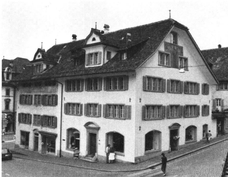
Schwyz, Haus Rickenbach. Die Westseite des Schwyzer Hauptplatzes wird durch das Doppelhaus Rickenbach-Castell dominiert. Dieses entstand unmittelbar nach dem Dorfbrand von 1642.
