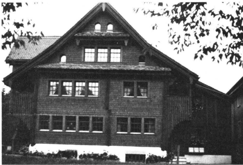
Arth, Haus Haider-Eigel. Das bisher unbeachtete kleine Häuschen am südli- chen Dorfrand von Arth hat dank einer sorgfälti- gen Sanierung sein ange- stammtes Bild zurücker- halten.
