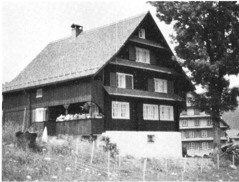
Oberiberg, Bauernhaus Johannisberg. Nach der Restaurierung. Blick auf die Hauptfront.
