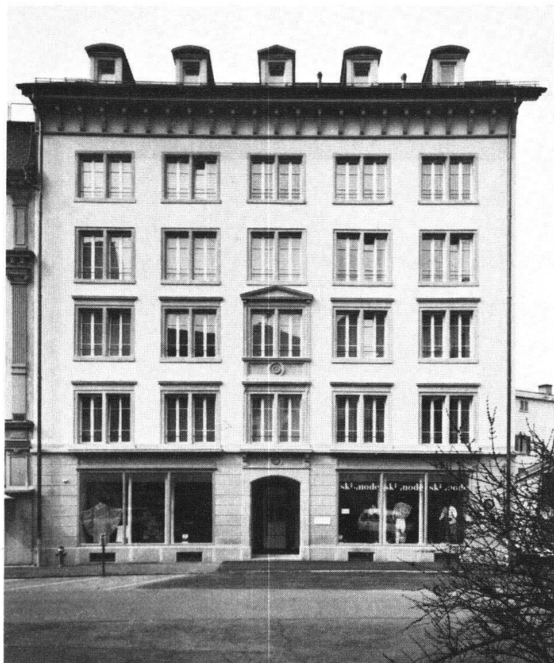
Einsiedeln, Haus St. Anton. Die streng klassizistische Fassadengestaltung verrät städtischen Einfluß.
