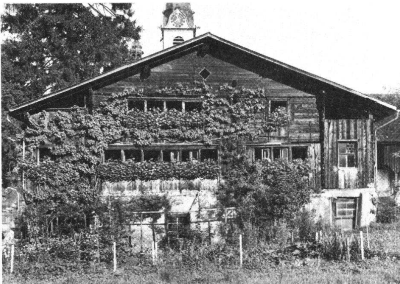
Schwyz, Haus Bethlehem von Süden. Mit Ausnahme der beiden seitlichen Lauben wurde das Haus 1287 erbaut. Im späten 17. Jahrhundert dürften die Fenster in ihrer Größe verändert worden sein.
