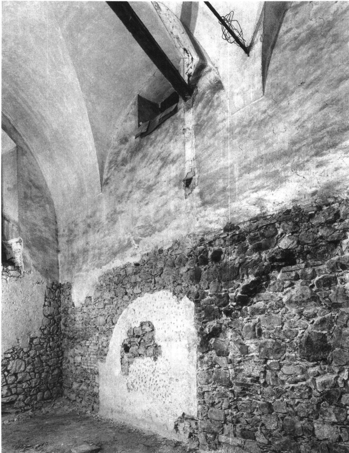
Abbildung 29 Nazareth, Westwand, Südteil; Ansicht von Nordosten.
