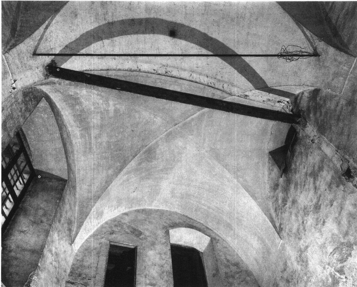
Abbildung 24 Nazareth, südliches Gewölbejoch; Ansicht gegen Süden. Erkennbar ist rechts der nachträglich umgestaltete Eingang von der Empore her sowie links eine Wandnische.
