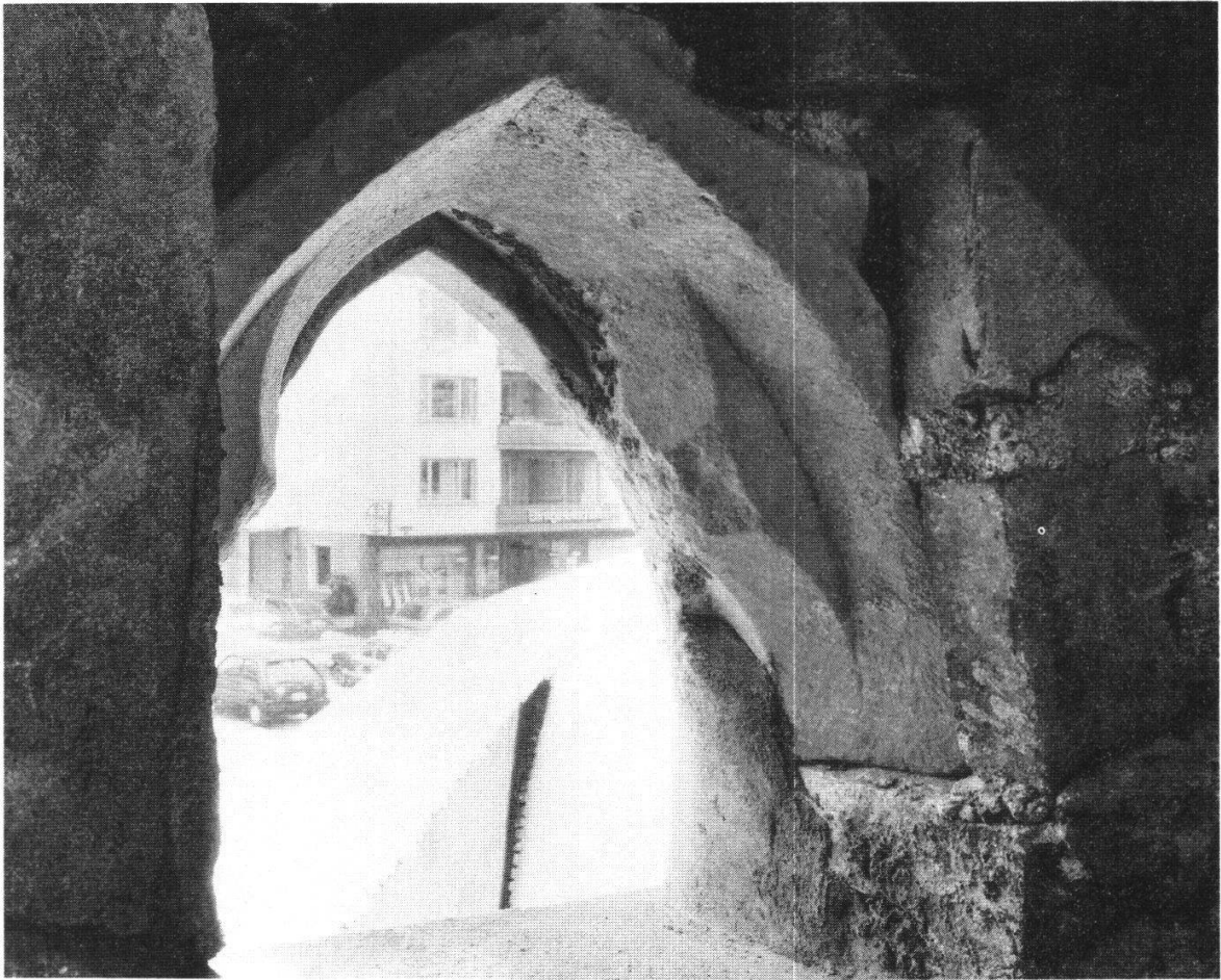
Abbildung 39 Nazareth, nördliche Giebelwand, Ostfenster mit wiederverwendetem Maßwerk-Fragment eines Lanzettfensters; Schrägansicht von Südwesten.
