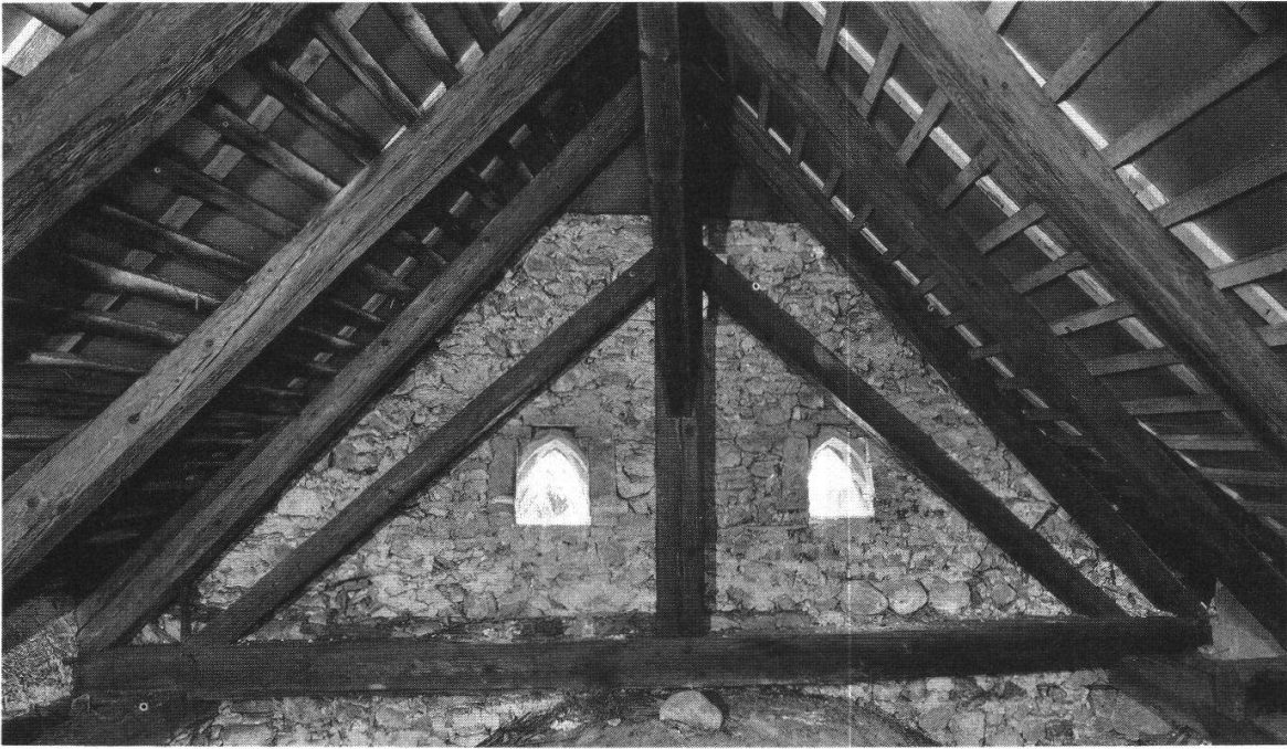
Abbildung 33 Nazareth, Dachgeschoß; Ansicht des Dachstuhls sowie der nördlichen Giebelwand.
