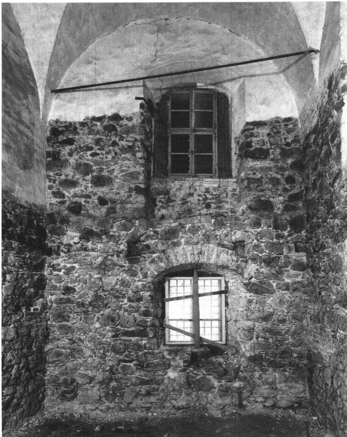
Abbildung 32 Nazareth, Ansicht der Nordwand. Die sichtbaren Balkenlöcher stammen vom Einzug einer Holzdecke im 19. Jahrhundert.
