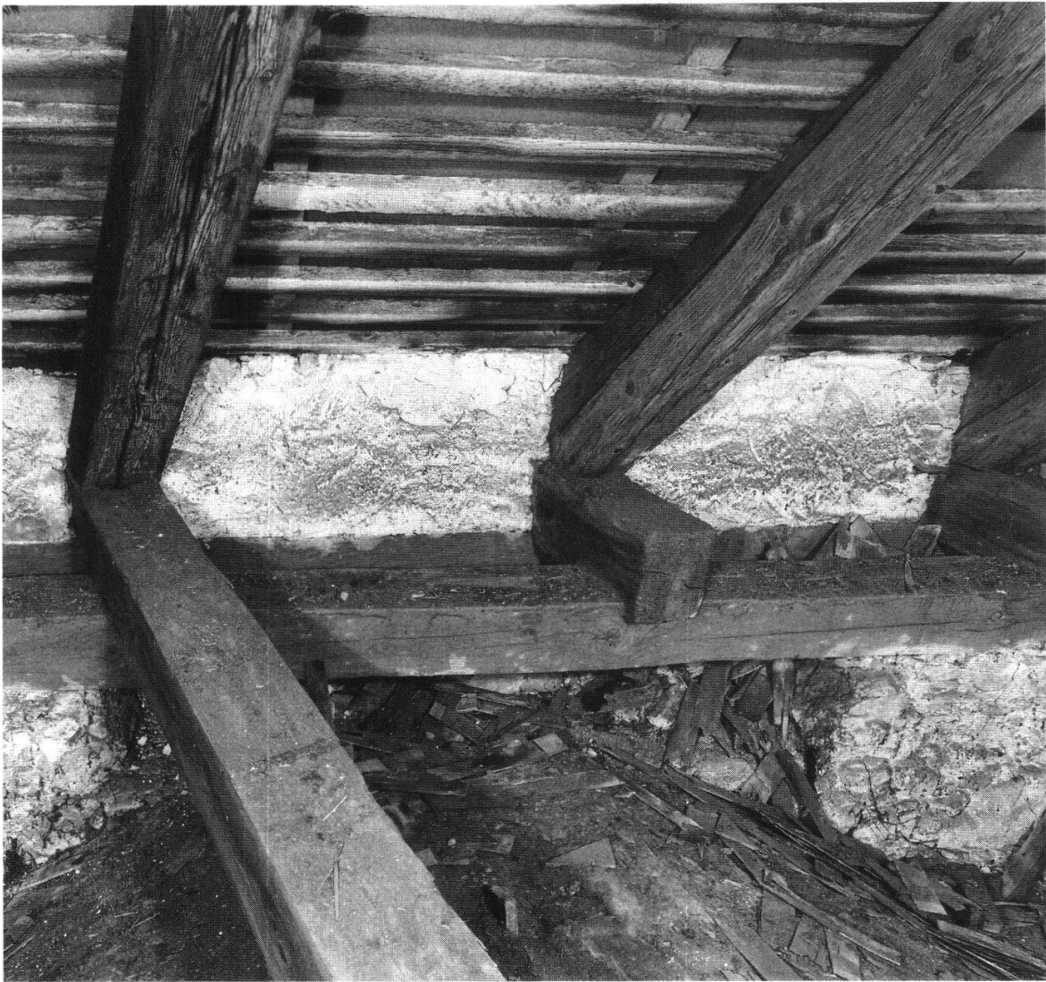
Abbildung 30 Nazareth, Dachgeschoß, Westwand mit ursprünglichem Verputz, welcher gegen die Dachstuhlkonstruktion zieht. Im Vordergrund: Gewölbekealotte.
