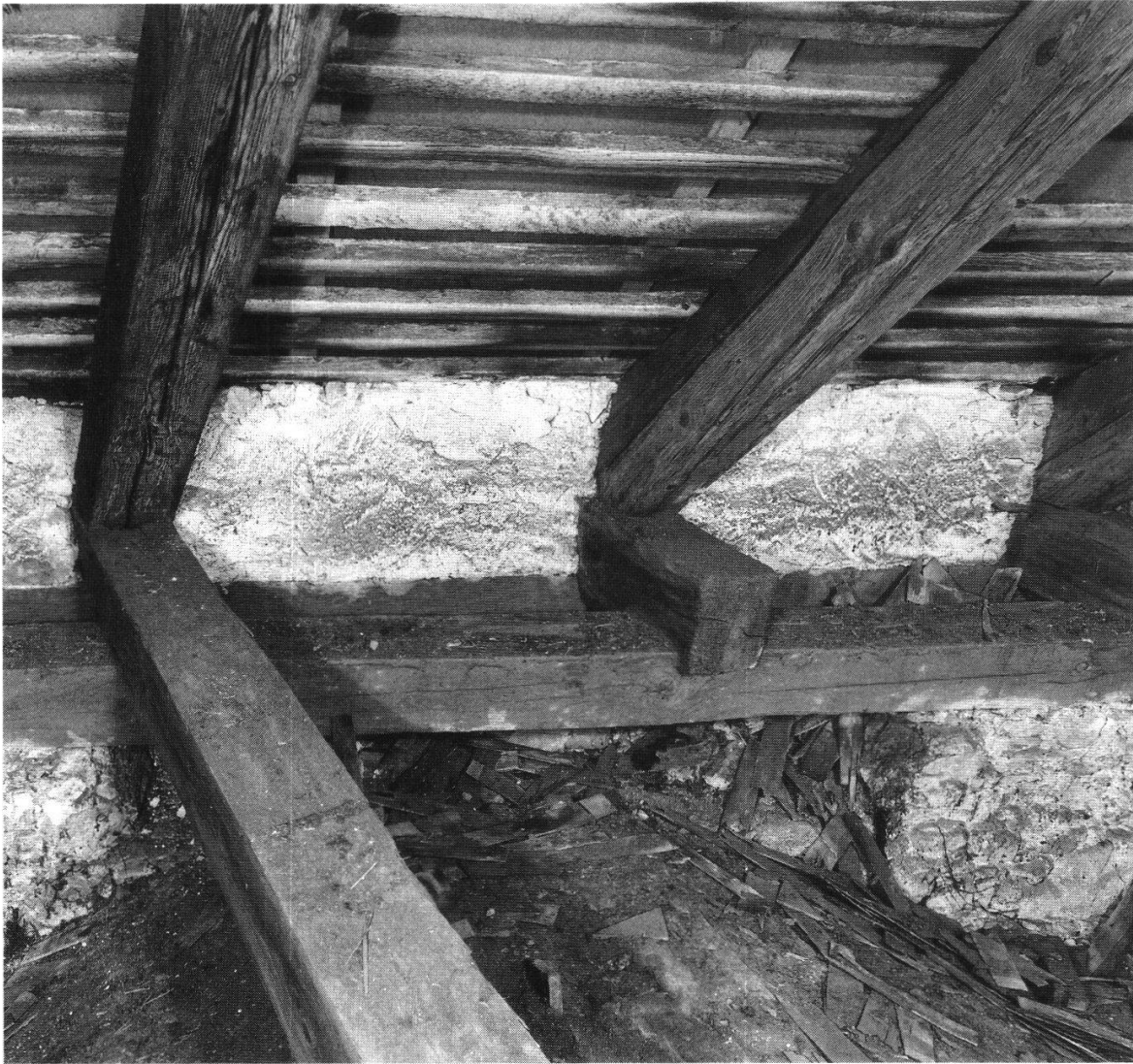
Abbildung 30 Nazareth, Dachgeschoß, Westwand mit ursprünglichem Verputz, welcher gegen die Dachstuhlkonstruktion zieht. Im Vordergrund: Gewölbekalotte.
