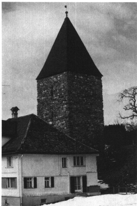
Rothenthurm; Letziturm, das rote Schindeldach überragt als Wahrzeichen die Häuser der Umgebung
