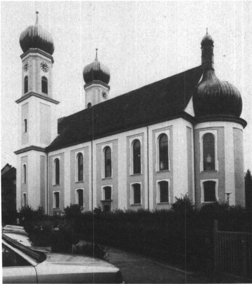
Lachen; Pfarrkirche Heilig Kreuz, der monumentale Bau zeigt nach der Restaurierung seine ursprüngliche Architekturgliederung
