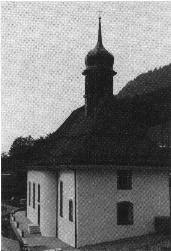
Riemenstalden; Außenansicht der restaurierten Pfarrkirche. Gut zu erkennen sind der Dachbelag in sogenannter Steinschieferdeckung sowie das formal nach alten Ansichten verbesserte Dachreiterchen
