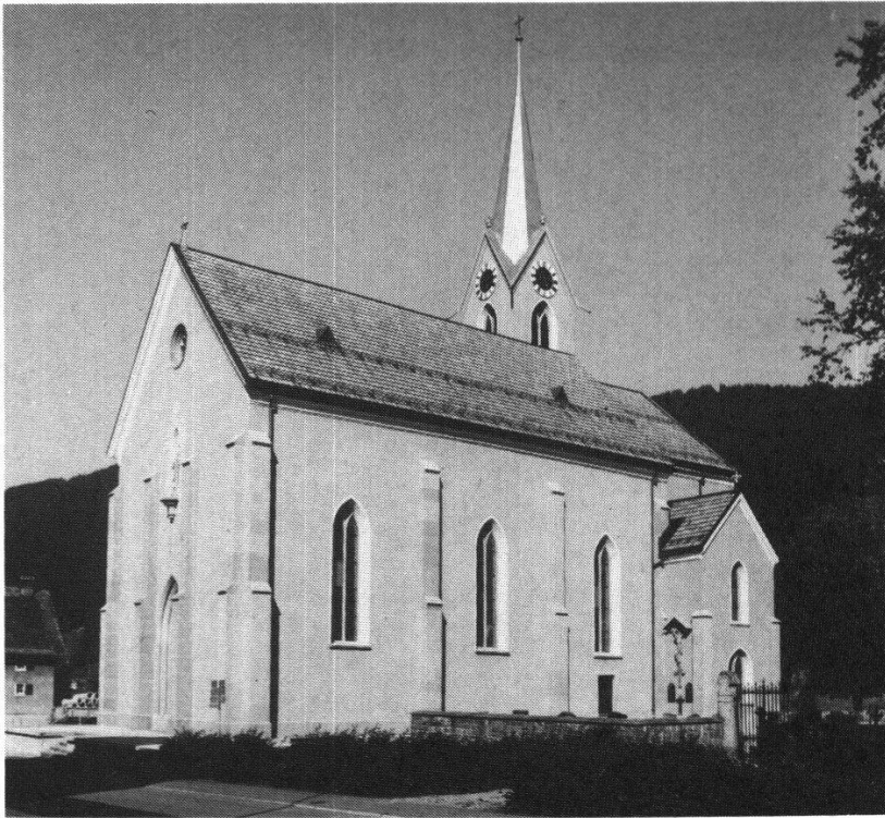
Alpthal; Außenansicht der restaurierten neugotischen Pfarrkirche
