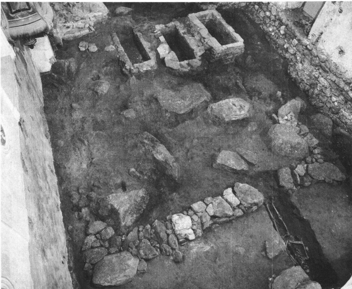
Abbildung 9 Anlage I, Ansicht von Nordwesten. Im Vordergrund ist die Fundamentunterlage der Westmauer mit den beiden Ecken des Langhauses zu erkennen.
