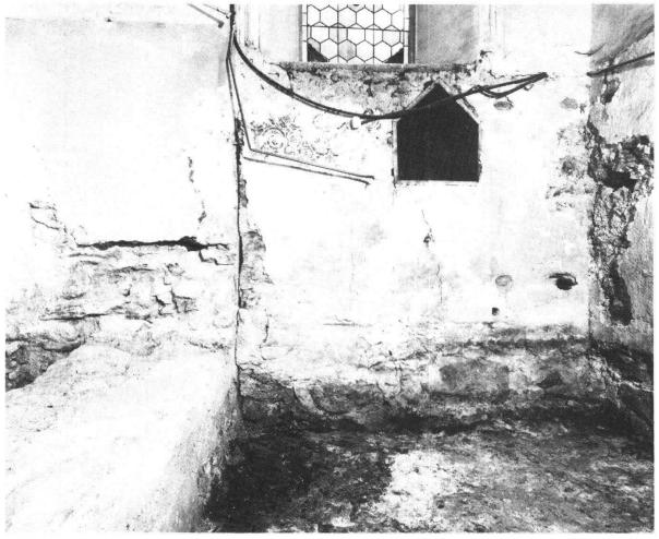
Abbildung 20 Anstoß der Chor-Ostwand III (rechts) gegen die verputzte Südostecke von Anlage II; links die Chor-Südmauer II; rechts der Mitte das «einfältig gemachte Sacramentsghüs» von 1509. Im Vordergrund sichtbar das dritte Bauniveau der Anlage III.
