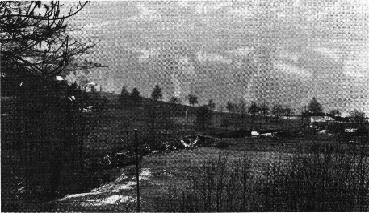
Letzi Arth/Sonnenberg. Blick von Nordwesten (Feindseite) auf die Letzi. Die Mauer folgte dem als Graben genutzten, natürlichen Bachlauf.
