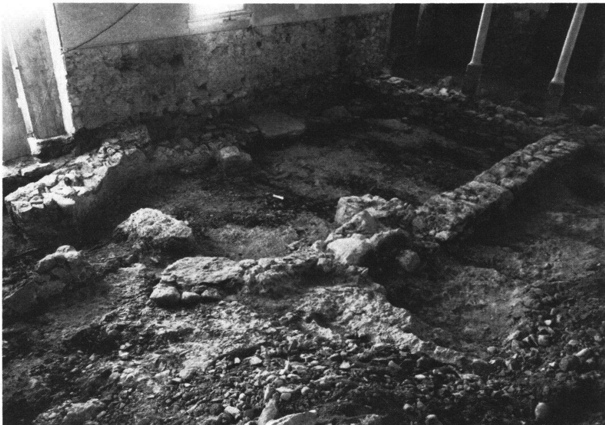
Die Kapelle von 1501 gegen Südwesten. Unter den Emporenstützen die Westmauer «R» von 1572.
