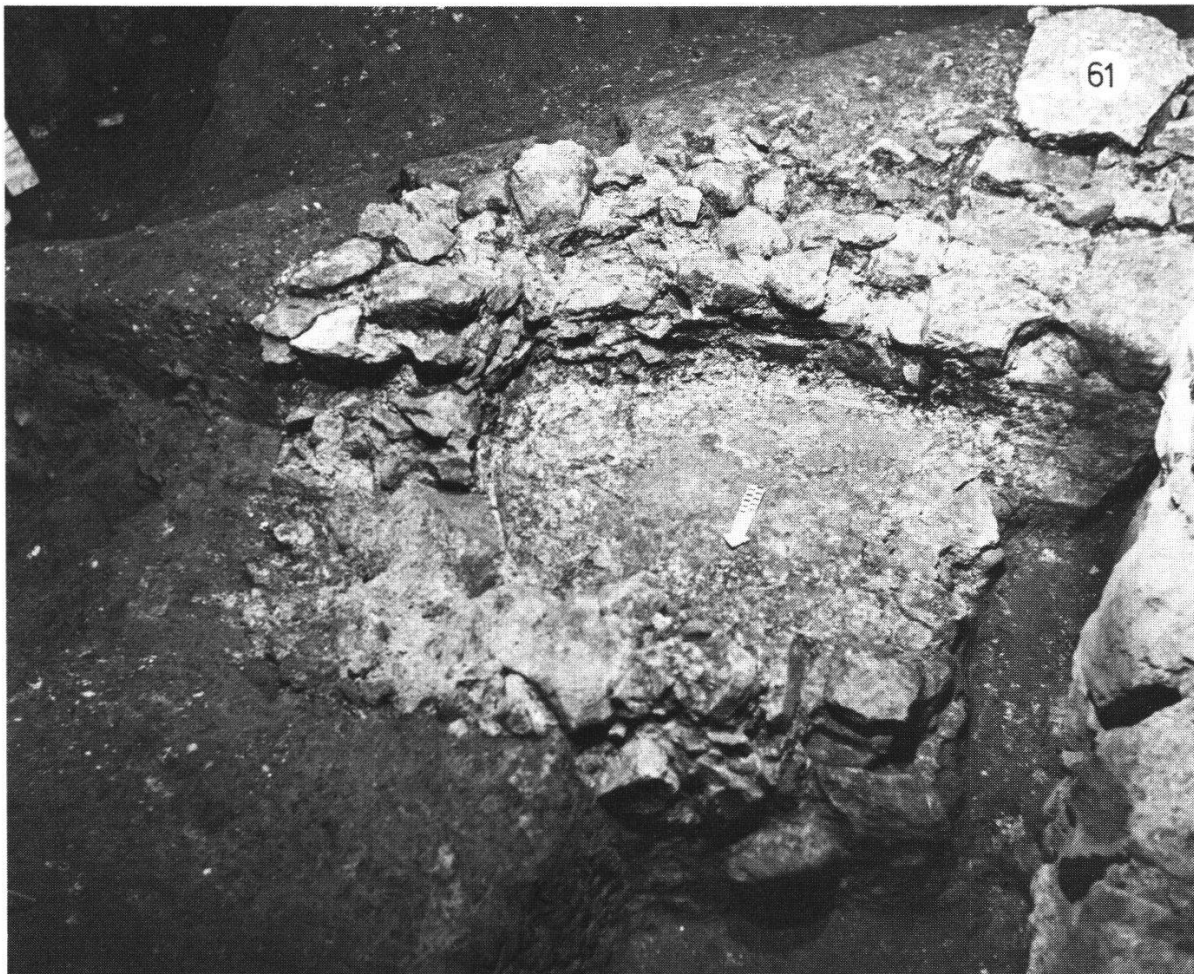
Abb. 26 Südwestliche Chorecke mit Mauerwinkel Nr. 61 und sekundär angesetzter Apsidiole, deren Mörtelboden im Innern mit Ziegelmehl bestreut ist.
