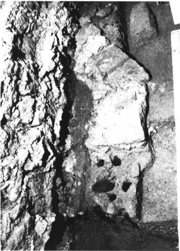
Abb. 15 Magdalenenkapelle: Fundamentenreste der Süd- und südöstlichen Chormauern samt Negativen der Fundament-Pfählung.
