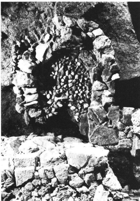
Abb. 28 Aufsicht auf die Apsidiol mit freigelegter Kieselrollierung des älteren Mörtelbodens.
