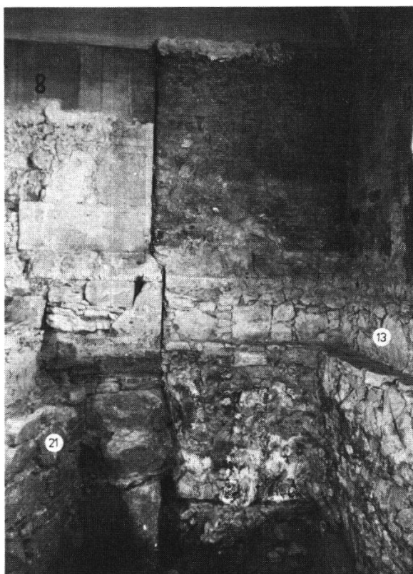
Abb. 10 Nordostecke des Kuenchores (Nr.8) mit Eckquadern; Ansicht gegen Westen. Von Norden (d.h. von rechts) sekundär unter Kraus angebaute Sakristeiostmauer (Fundament gegen Bretterschalung gegossen), Nr. 13 Sakristei-Nordmauer.
