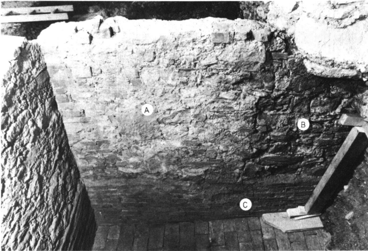
Abb. 13 Blick in die Gruft Nr. 38 (Nordwand) mit den drei Bauetappen: «A» ältester Teil, «B» erste Verlängerung nach Osten und «C» zweite Verlängerung nach Osten mit gleichzeitigem Abtiefen der Gruft und Anlage eines neuen Bodens (Tonplatten).
