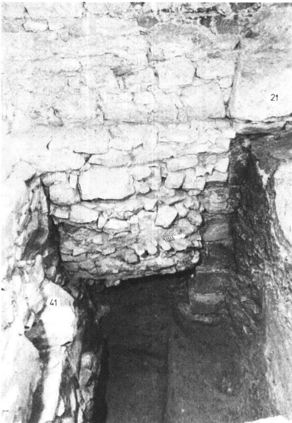
Abb. 11 Südostecke des Kuenchores (Nr. 21); ganz links im Süden die Mauer des Durchganges (Nr.41) südlich entlang des Chores aus der Zeit des Fraterstock-Baues, dazwischen das eingestellte Kraussche Fundament zur heutigen Sakristei von Kraus.
