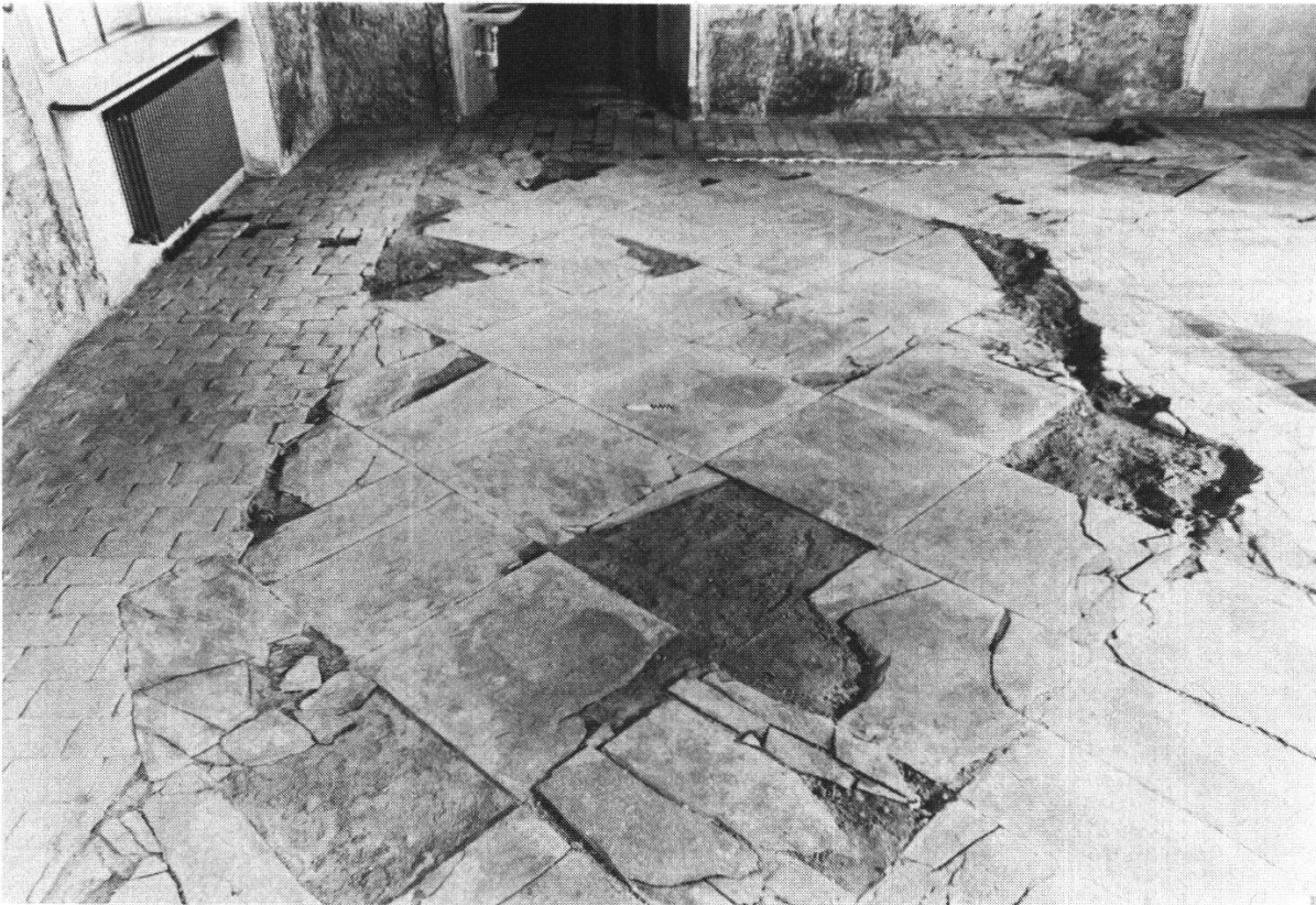
Abb. 6 Sakristei, Nordost-Ecke: Reste des originalen Schieferplattenbodens, im Bereich der Einbauten eine Unterlage aus Backsteinen.
