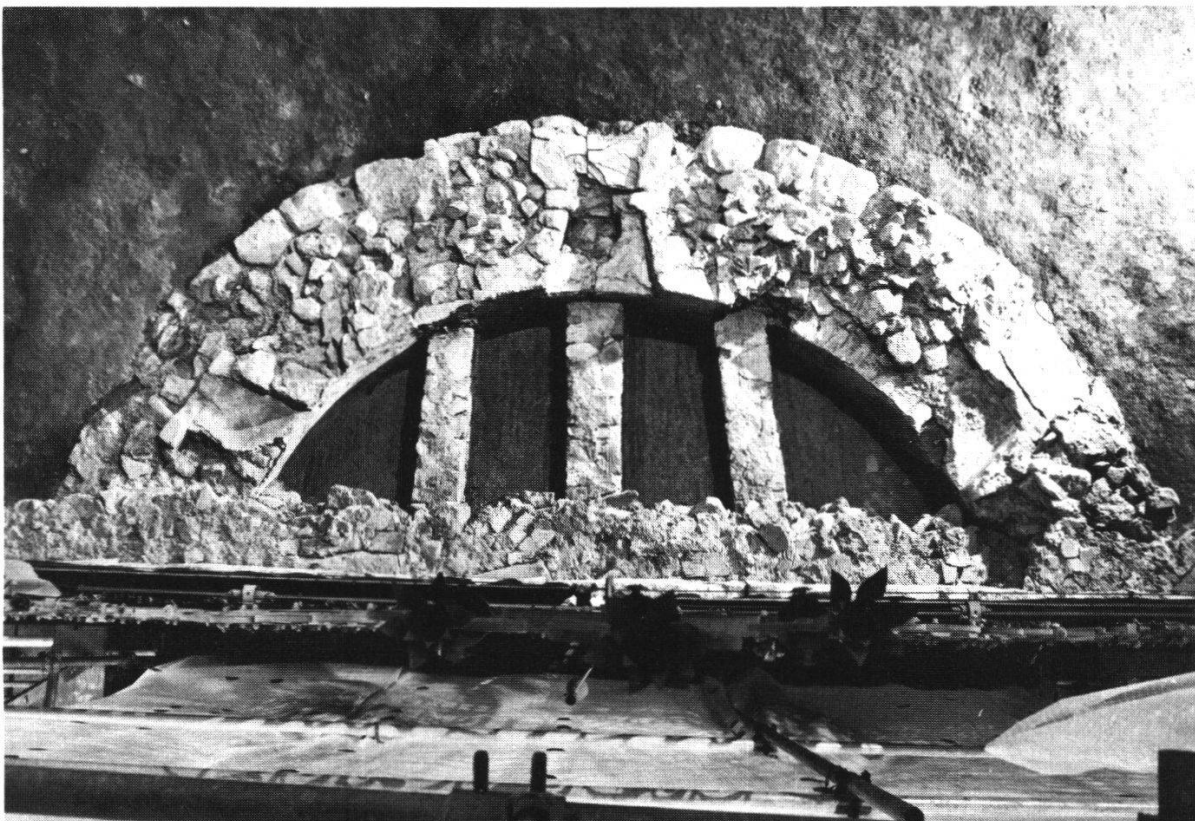
Abb. 18 Aufsicht vom Chorgitter auf den romanischen Kryptenschluß mit den Resten von drei Fenstern. Im Krypteninnern gemauerte Abt-Grüfte.
