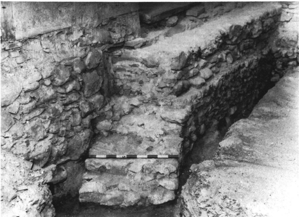
Abb. 58 Fundament mit Ansatz des Aufgehenden zur Südmauer des polygonalen Chörleins von 1616, erste Abwinkelung.
