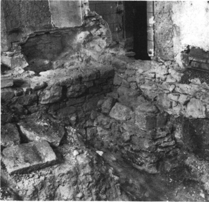
Abb. 57 Südecke des Inneren Chores. Triumphbogen-Fundament und Ansatz der Seitenmauer des Chörleins von 1616. Die Türe führt ins Altarhaus.
